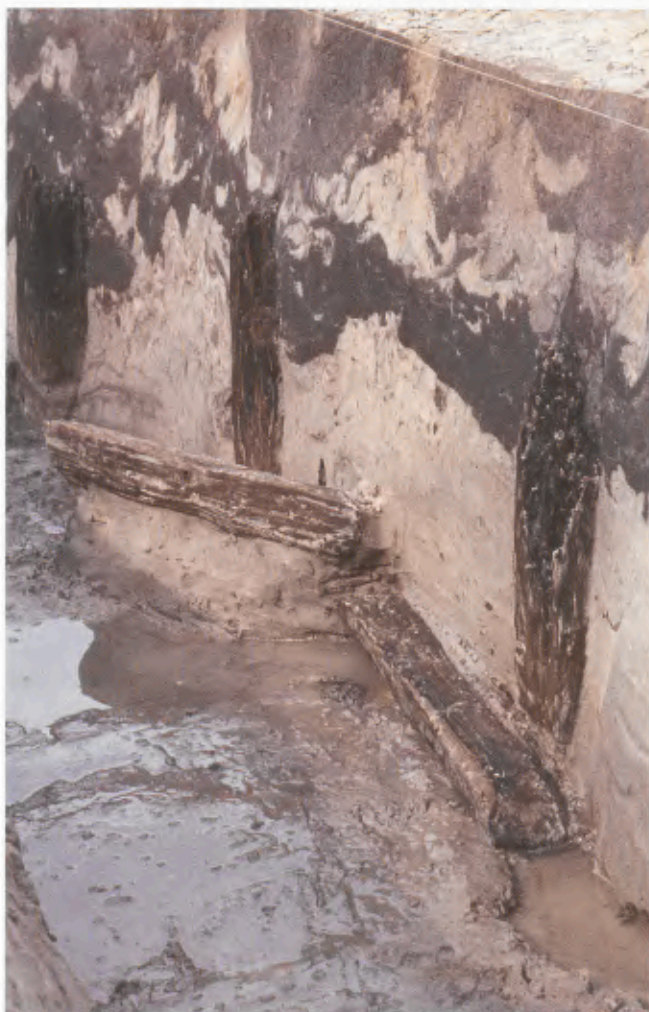
58 Oberaden. Pfostenstümpfe der Holz-Erde-Mauer mit unterlegten Querhölzern als Stabilisatoren im feuchten Untergrund.
