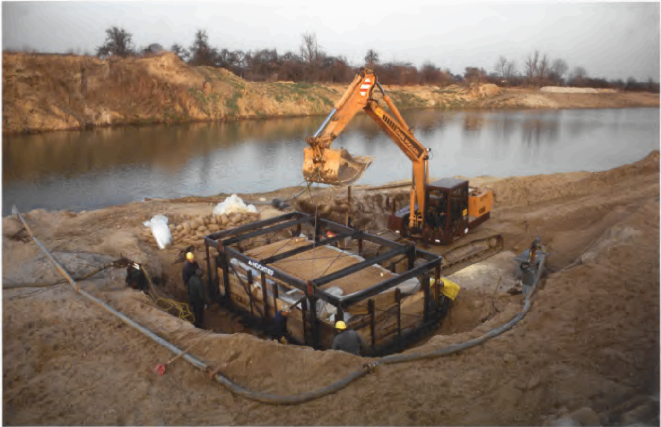
359 Verbau des Schiffskörpers.
