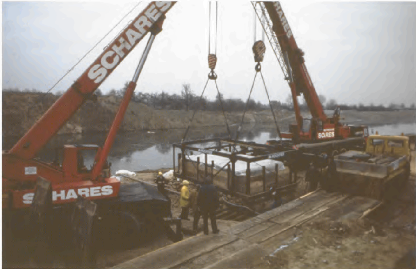
360 Anheben des Schiffskörpers mit zwei Autokränen.
