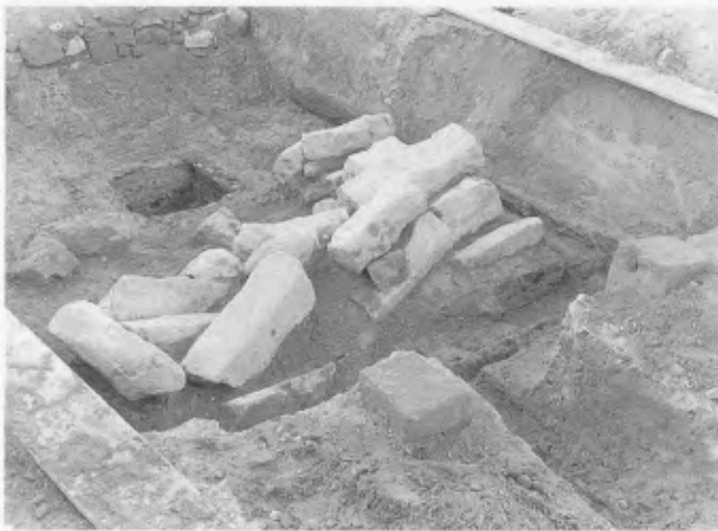
229 Grabung 1935. Arenakeller mit den in situ befindlichen steinernen und eisernen Kontergewichten des Aufzugs.
