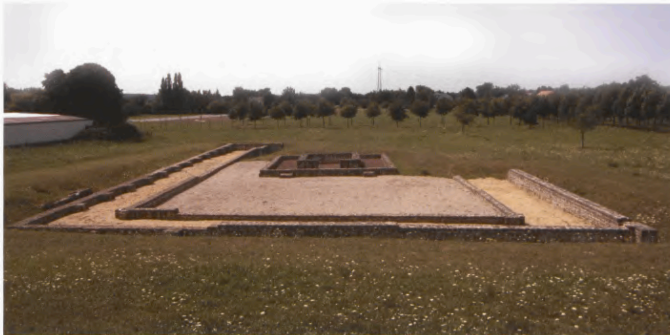
193 Matronentempelbezirk. Situation nach der Sicherung der Fundamente 1993/94.
