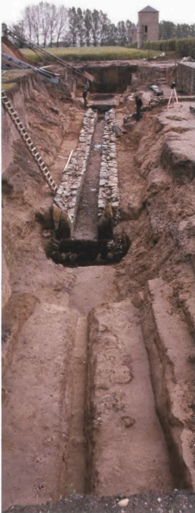
259 Kanalisation im Straßengraben, nördlich des Burginatum-Tores, um 1990.
