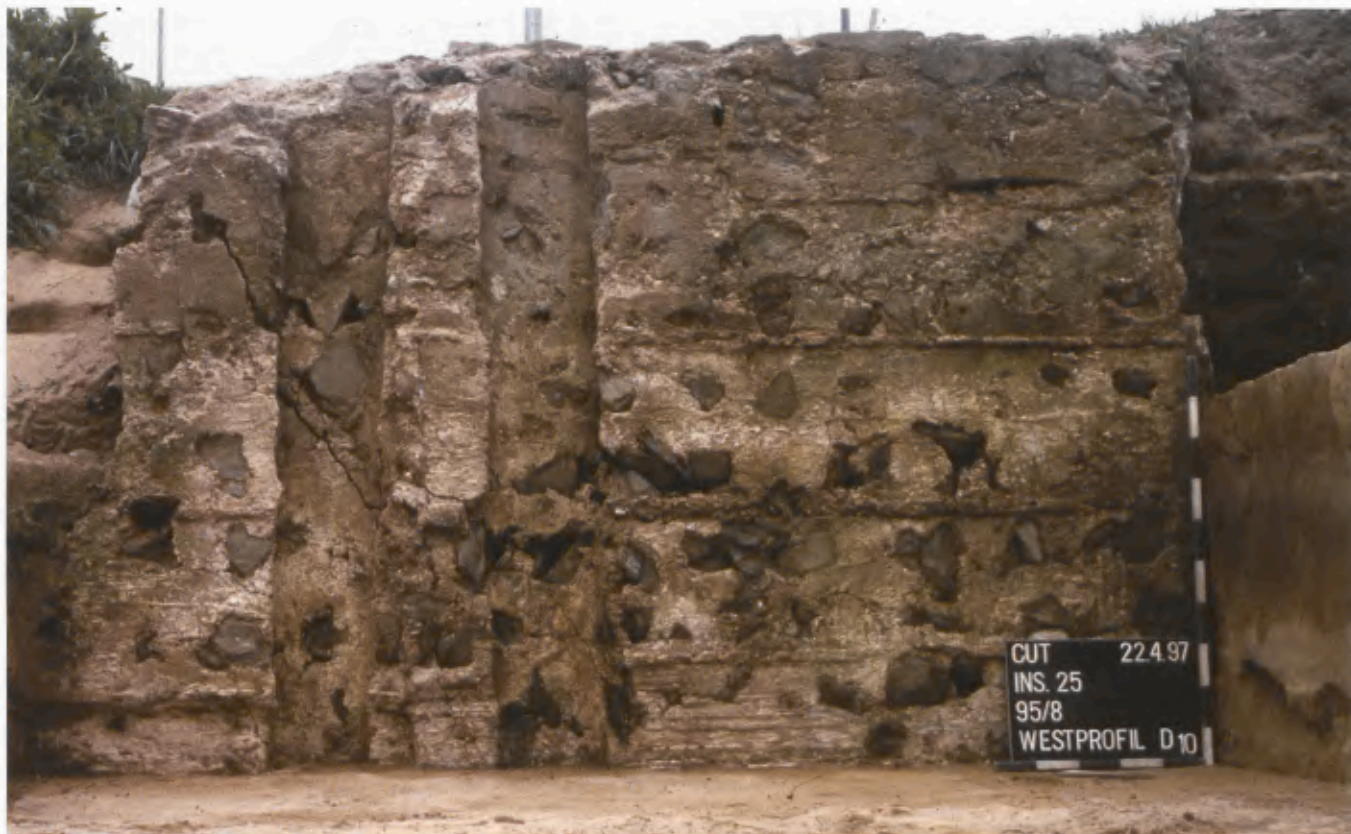
204 Westmauer der Forumsbasilika aus opus caementicium mit Abdrücken der Holzverschalung.
