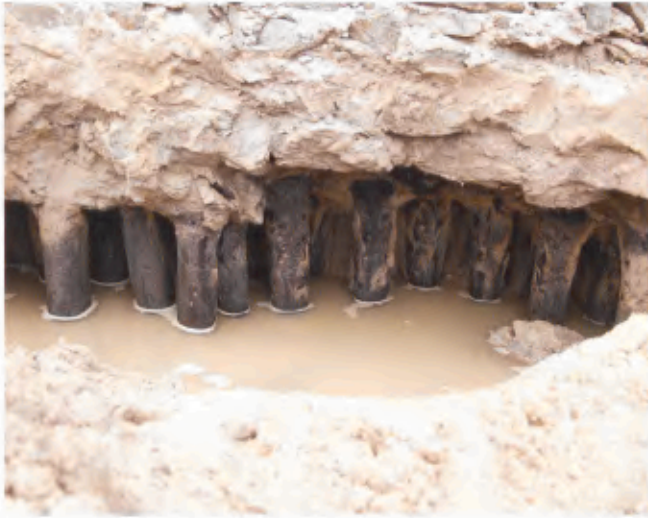
234 Große Thermen, Insula 10. Eichenpfahlrost unter der Nordwestmauer der basilica thermarum .
