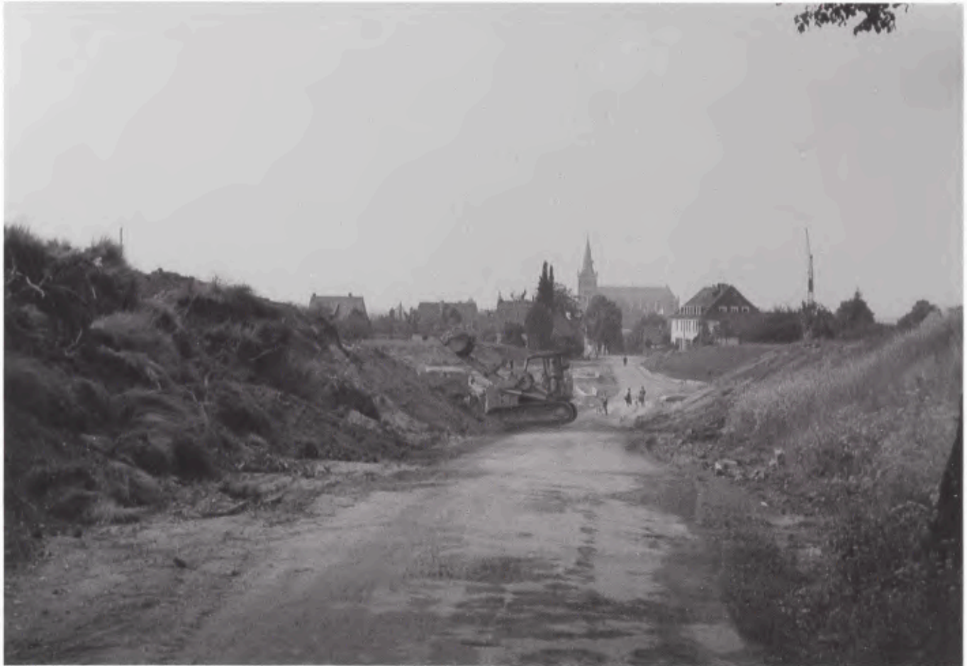
147 Straßenbau Viktorstraße/Fürstenberg 1963, Blick nach Nordosten.
