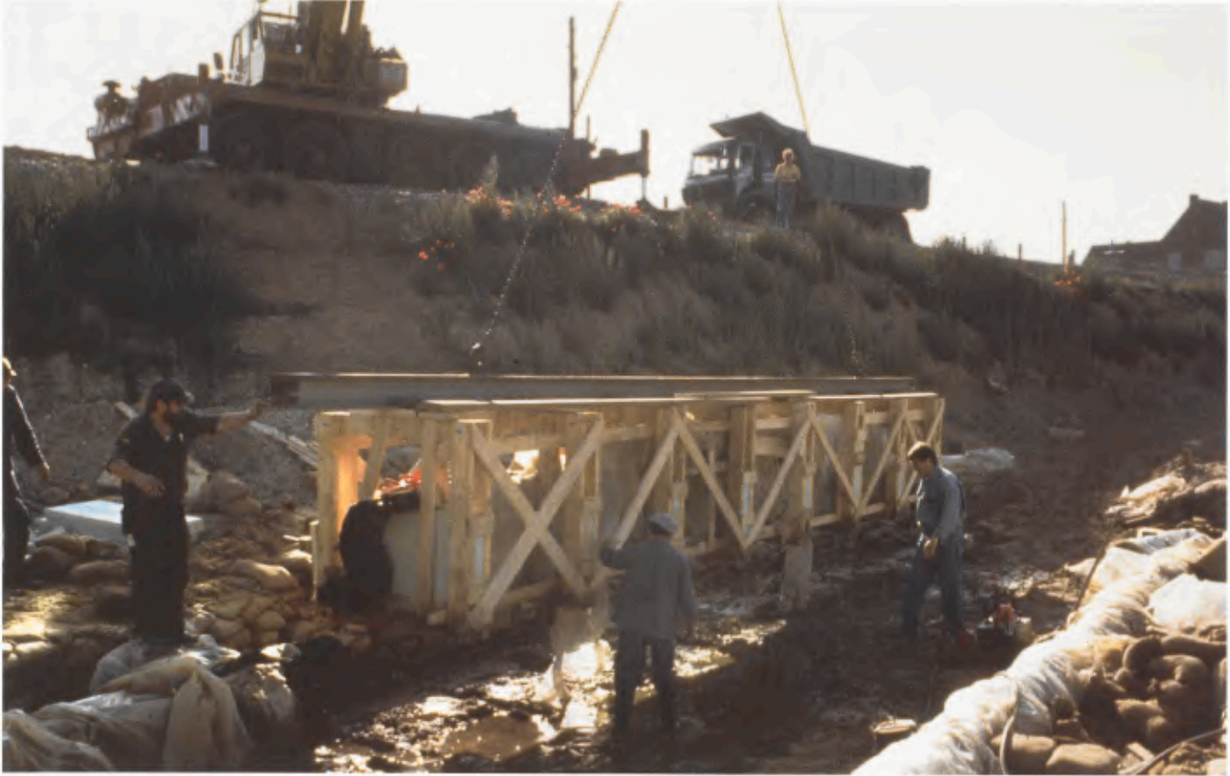
375 Verbau des Schiffskörpers.
