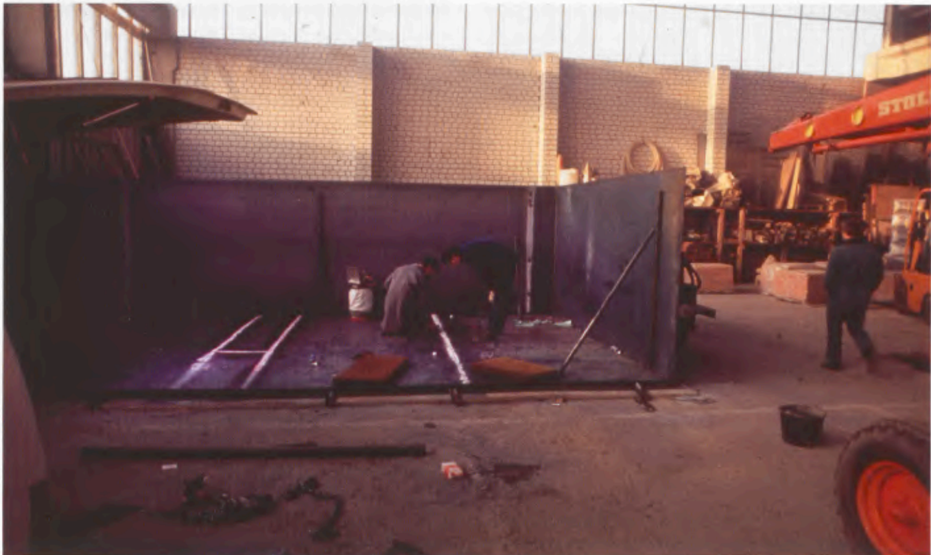
361 Bau des Wasserbeckens.
