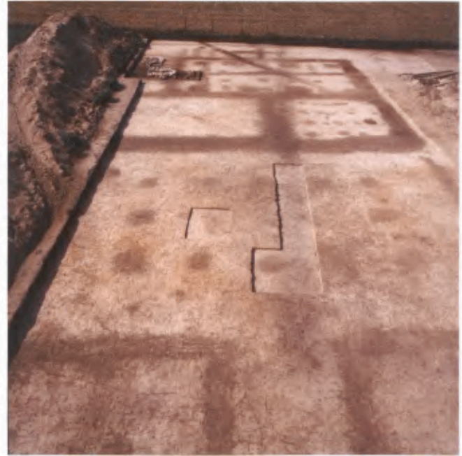
64 Anreppen. Blick von Süden auf die Lagerthermen. Im Vordergrund ist der Peristylhof erkennbar. Die eigentlichen Baderäume liegen in der hinteren Bildhälfte.
