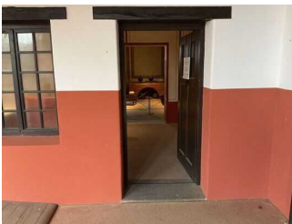
Tür zur Küche
