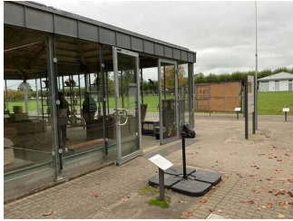
Tür zur Halle Bauen und Technik
