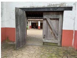
Tür vom Innenhof Badehaus zum Hauptweg
