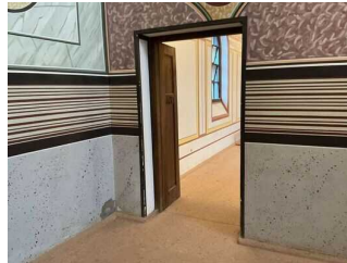
Türen zwischen den Baderäumen
