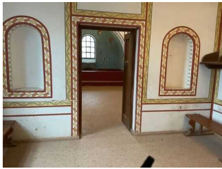
Türen zwischen den Baderäumen
