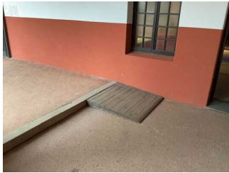
Rampe vom Innenhof zum Garten
