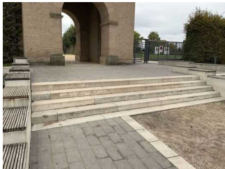
Treppe von Kasse Hafentempel zum Eingang Park
