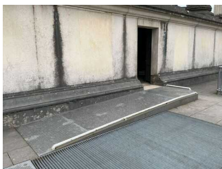
Rampe zur Ausstellung im Hafentempel
