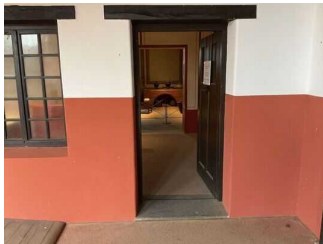
Tür zur Küche
