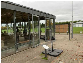
Bauen und Technik
