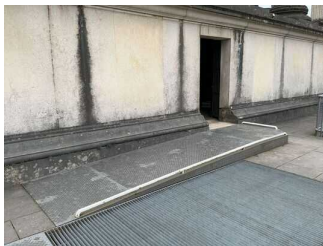
Rampe zur Ausstellung im Hafentempel
