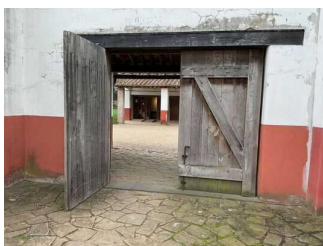
Tür vom Innenhof Badehaus zum Hauptweg
