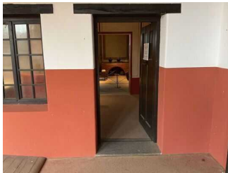
Tür zur Küche
