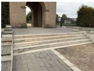
Treppe von Kasse Hafentempel zum Eingang Park
