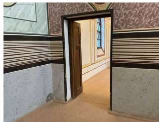
Türen zwischen den Baderäumen
