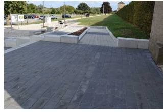
Rampe Kasse Hafentempel zum Parkeingang
