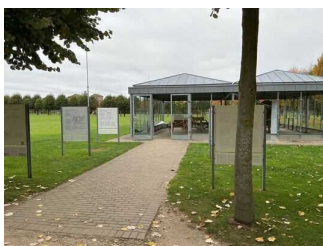
Tür zur Halle Straßen und Verkehr
