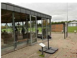
Tür zur Halle Bauen und Technik
