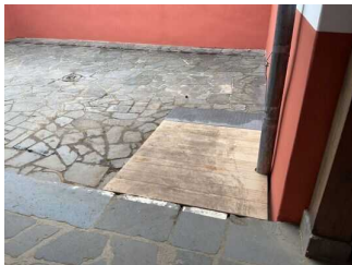
Rampe vom Badehaus zum Innenhof
