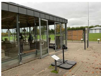
Bauen und Technik
