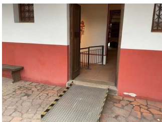
Rampe für die Ausgänge zum Innenhöfen
