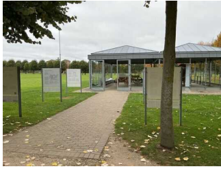
Tür zur Halle Straßen und Verkehr
