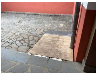
Rampe vom Badehaus zum Innenhof
