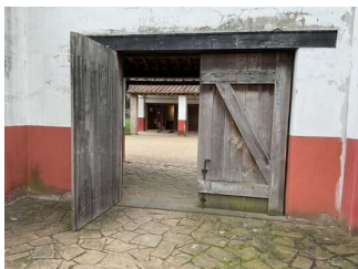
Tür vom Innenhof Badehaus zum Hauptweg
