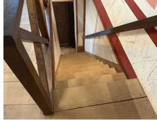
Treppe zum 1. OG Schlafräume
