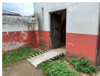
Rampe für die Ausgänge zum Innenhöfen
