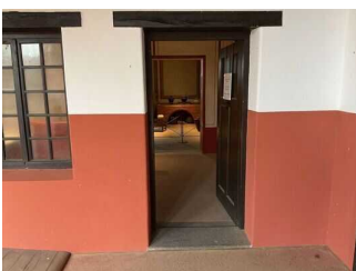
Tür zur Küche
