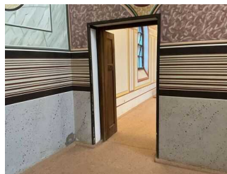
Türen zwischen den Baderäumen
