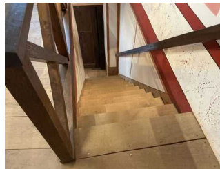
Treppe zum 1. OG Schlafräume
