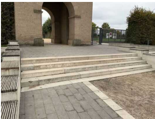
Treppe von Kasse Hafentempel zum Eingang Park
