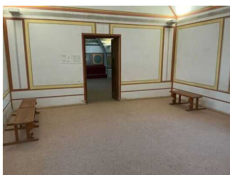
Türen zwischen den Baderäumen
