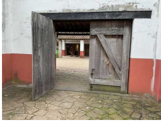
Tür vom Innenhof Badehaus zum Hauptweg
