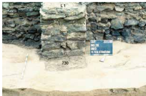
Abb. 122 Schnitt 98/2, Mauer M 25 mit Mauervorlage L 1 sowie Vorlagenbaugrube 730, von Süden.
