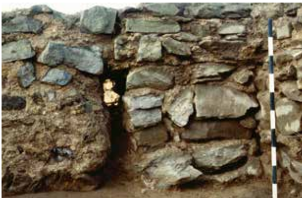
Abb. 124 Schnitt 98/2, Maueransatz M 22 an Mauervorlage L 2 sowie Mauer M 25. Deutlich ist der obere Verbund der Bauteile L 1 und M 25 sichtbar, von Osten.
