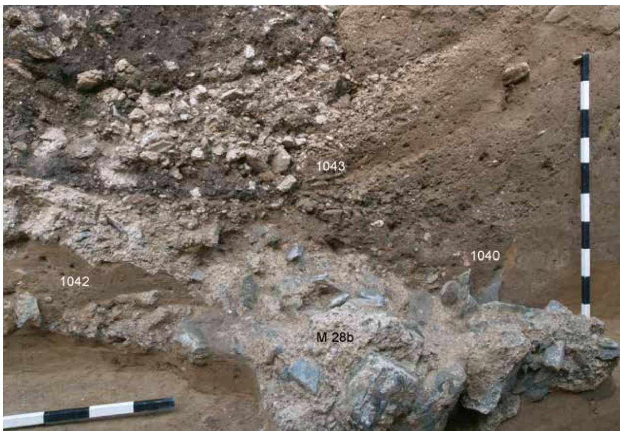
Abb. 152 Schnitt 2009/04, Nordprofil A1, Sohlenbereich der Mauer M 28b.
