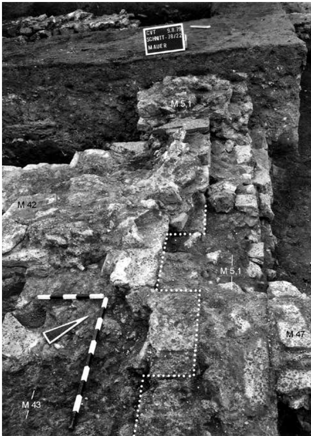
Abb. 185 Schnitt 78/22 D, Mauern M 42, M 43 mit Überbauung der Mauer M 5,1, von Süden.
