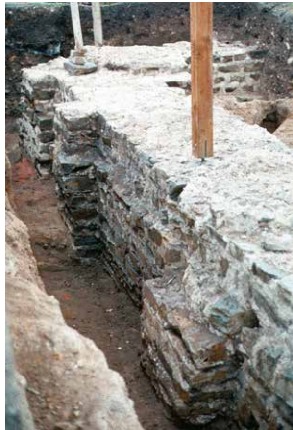
Abb. 186 Schnitt 82/9, Mauer M 43 mit Baugrube 994 (z. T. abgegraben), im Vordergrund abgeschrotete Lisene für Fundierung der Mauer M 5,1, von Nordosten.
