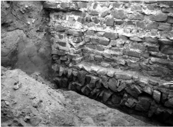
Abb. 182 Schnitt 82/4, Nordansicht Mauer M 42, Arbeitsfugen und Baugrube 941, von Nordwesten.
