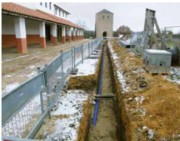
Abb. 27 Xanten, Colonia Ulpia Traiana. Insula 39. Anlage eines Versorgungsleitungsgrabens in der römischen Straße zwischen den Insulae 38 und 39.
