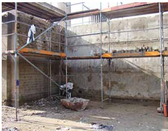
Abb. 34 Xanten, LVR-Archäologischer Park. Hafentempel. Sanierung der Cellawand.
