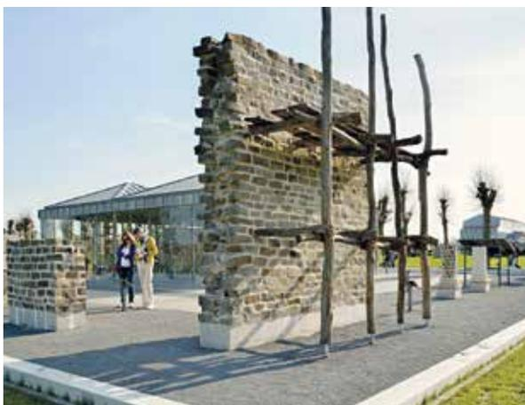
Abb. 32 Xanten, LVR-Archäologischer Park. Ausstellungspavillon Bauen und Technik. Bruchstein-Mauerwerk mit Gerüst.
