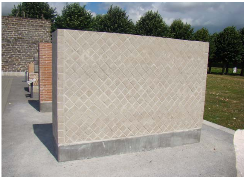
Abb. 23 Xanten, LVR-Archäologischer Park. Mauerprobe aus Opus reticulatum. Ausgeführt durch das Archäologische Institut der Universität zu Köln.
