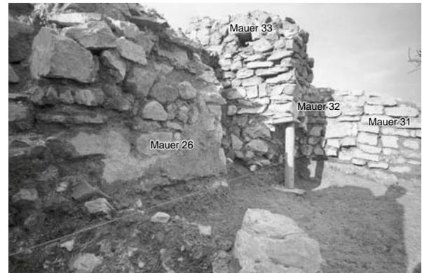
Abb. 31 Bad Münstereifel-Iversheim, Kalkbrennerei. Mauerecke 32 / 33 und Mauer 26. Im oberen Teil von Mau- er 33 befindet sich das Balkenloch. Blick nach Norden.
