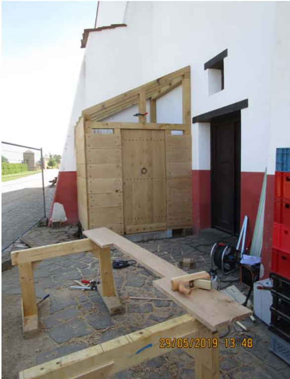
Abb. 53 Xanten, LVR-Archäologischer Park. Römischer Schuppen an der Herberge während des Bauprozesses.
