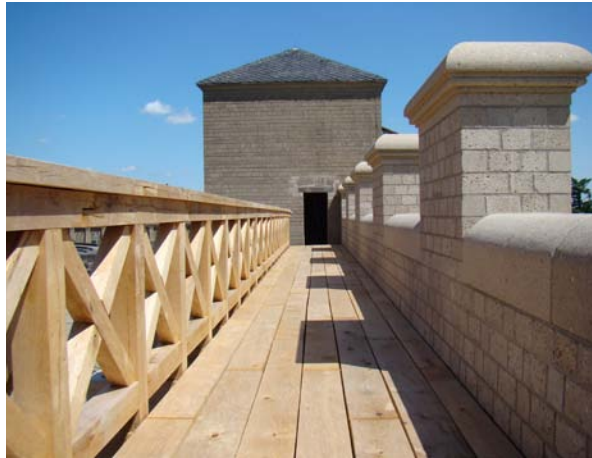
Abb. 57 Xanten, LVR-Archäologischer Park. Wehgang auf dem neuen Stadtmauerabschnitt.
