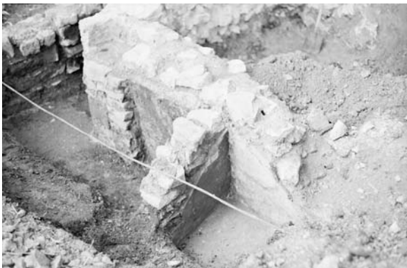
Abb. 36 Bad Münstereifel-Iversheim, Kalkbrennerei. Die Raumecke der Mauern 19 und 63 mit farbig bemaltem Wandputz. Blick nach Südwesten.
