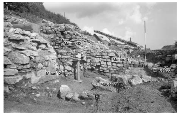
Abb. 33 Bad Münstereifel-Iversheim, Kalkbrennerei. Raum 11. Im Vordergrund Mauer 29. Blick nach Norden.
