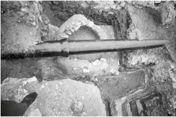
Abb. 28 Bad Münstereifel-Iversheim, Kalkbrennerei. Backofen auf Unterbau. Die Kuppel wurde durch die Wasserleitung zerstört.
