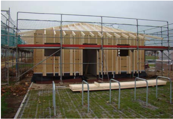
Abb. 19 Xanten, LVR-Archäologischer Park. Neubau des Kassenhauses am Westeingang. Holzbau im Bauzustand vom November 2018.
