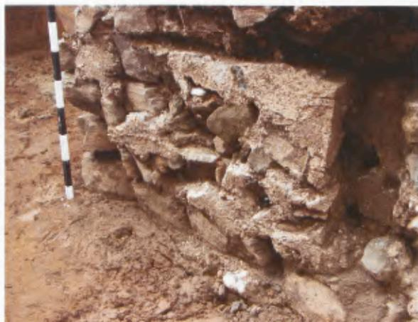
6 Xanten, Colonia Ulpia Traiana. Thermen Insula 10. Südöstliches Mauerfundament der *basilica thermarum* mit Verschalungsabdrücken in Schnitt 2004/04.
