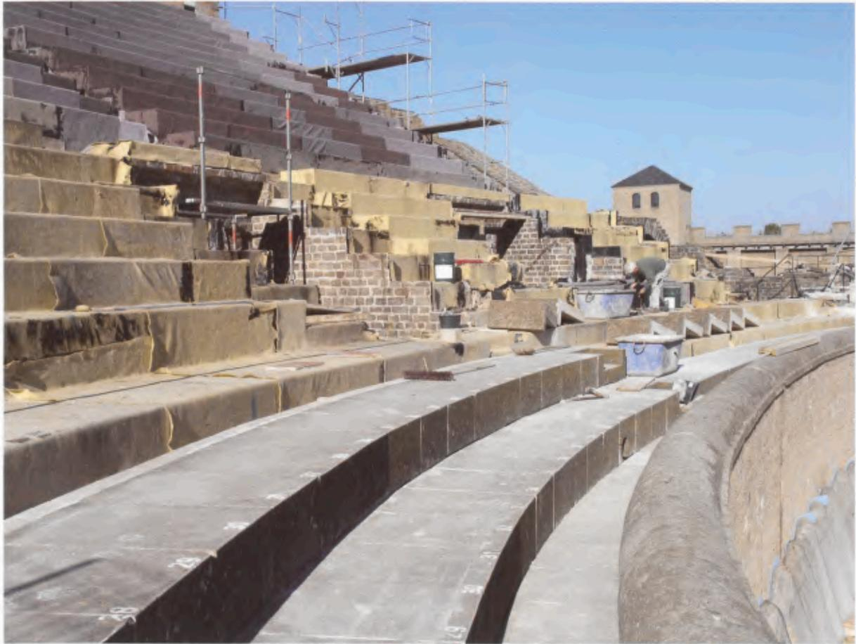
20 Xanten, Amphitheater. Sanierung der Sitzflächen der cavea mit Bitumen und Schutzvlies, Wiederversetzen der Stufen.
