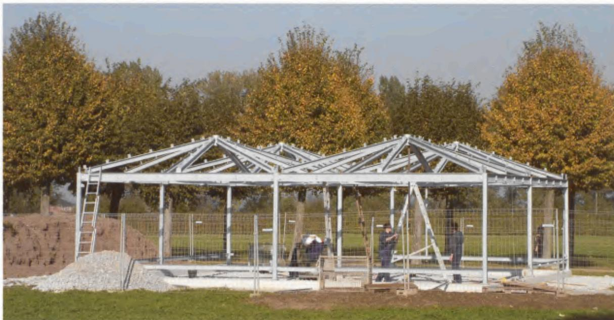
37 Archäologischer Park Xanten. Aufbau der Stahlkonstruktion des Kutschenpavillons.
