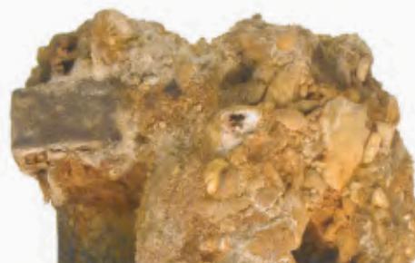
81 Spannrahmen, Rückseite mit Querträger 4 und dem im Bereich des Seitenständers 6 freiliegenden Beschlagblech 4.3, Vorzustand.
