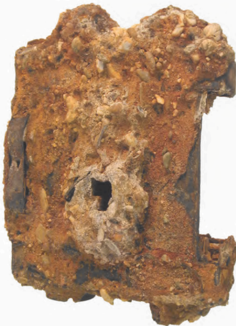
45 Vorderseite des Spannrahmens, Vorzustand. Im Bild rechts das teilweise frei liegende Frontblech 10.
