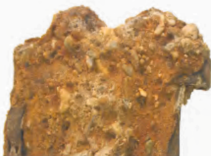
80 Spannrahmen, Front mit Querträger 4 und Beschlagblech 4.3, Vorzustand.
