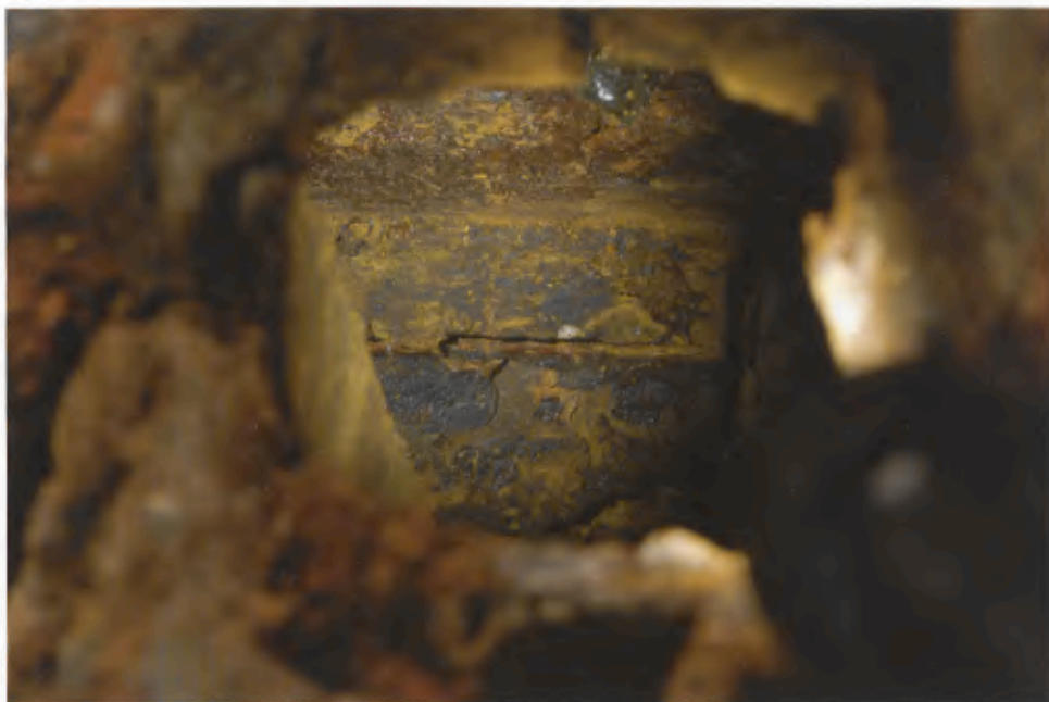
17 Hohlraum von Querträger 3 mit Eisenreif 3.1.
