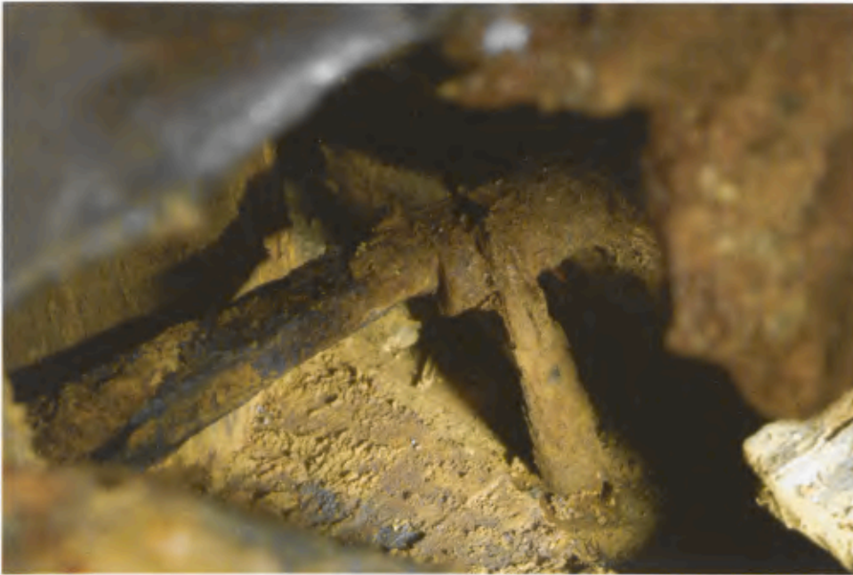
8 Hohlräume: Block 9, Mittelständer 8, Vierkantnagel 8.3 und Nagel für Beschlagplatte 12.
