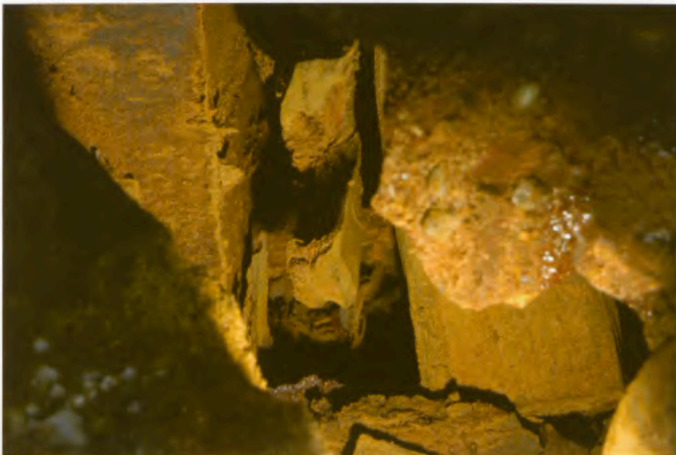
12 Zapfenverbindung in Mittelständer 7.
