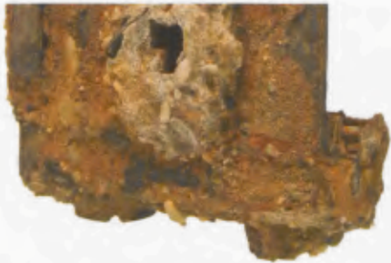
76 Spannrahmen, Front mit Querträger 3 und Beschlagblech 3.3, Vorzustand.
