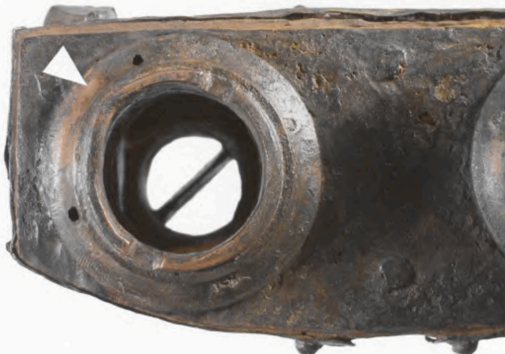
58 Spannbuchse C, Verformung des oberen Randes (Pfeil).
