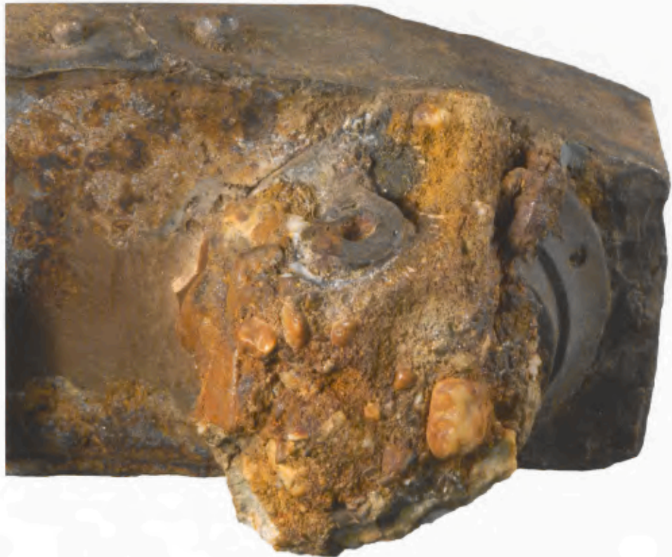
93 Spannbuchse B, links oben Vorstecker B 2 während der Freilegung.
