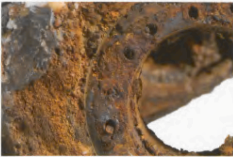
41 Aussparung für Spannbuchse D in Querträger 3 nach ihrer Abnahme. Links unten in der Aussparung ist der Absatz im Holz des Querträgers erkennbar.
