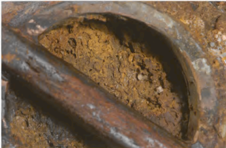
91 Spannbuchse A, Korrosionsschicht im Inneren, Detail.
