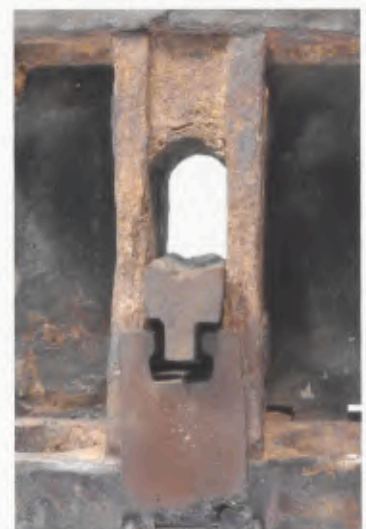
36 Abformungen von Pfeife 1 und Schieber 2 an ihrer ursprünglichen Position.
