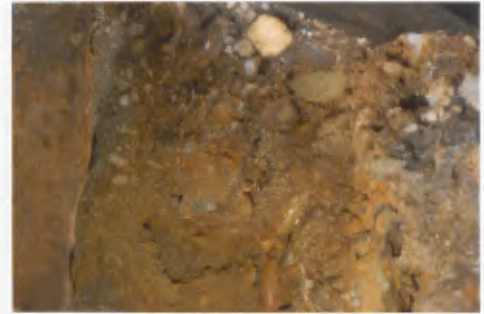
92 Spannbuchse A, Detail der Korrosionsschicht auf der Unterseite.
