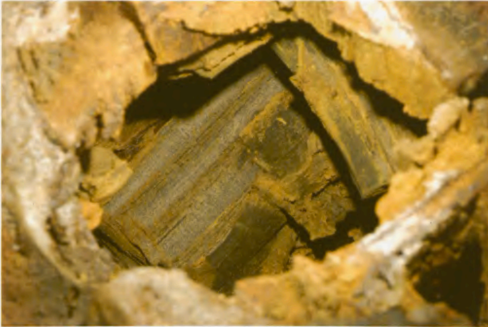
11 Reste der Zapfenverbindung in Querträger 3.
