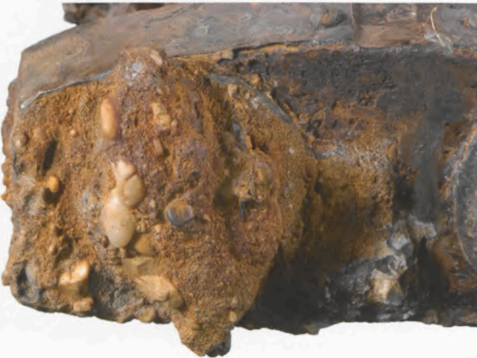
68 Querträger 3 mit Spannbuchse D. Vorzustand.
