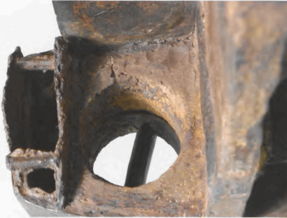
67 Eisenreif 3.1, im Bereich des ausgebrochenen Seitenständers 6 erkennbar.
