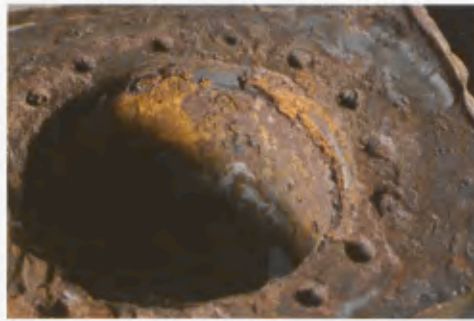
42 Aussparung für Spannbuchse D in Querträger 3 nach ihrer Abnahme. Rechts in der Aussparung ist der Absatz im Holz des Querträgers erkennbar.
