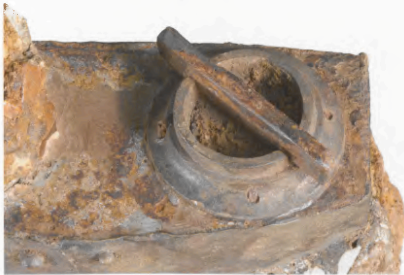
88 Spannbuchse A, Hohlraum und darunter befindlicher Belag aus Einschlüssen.
