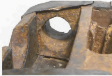
48 Querträger 3 mit Spannbuchse C; Aufnahme von unten aus der Seilkammer.
