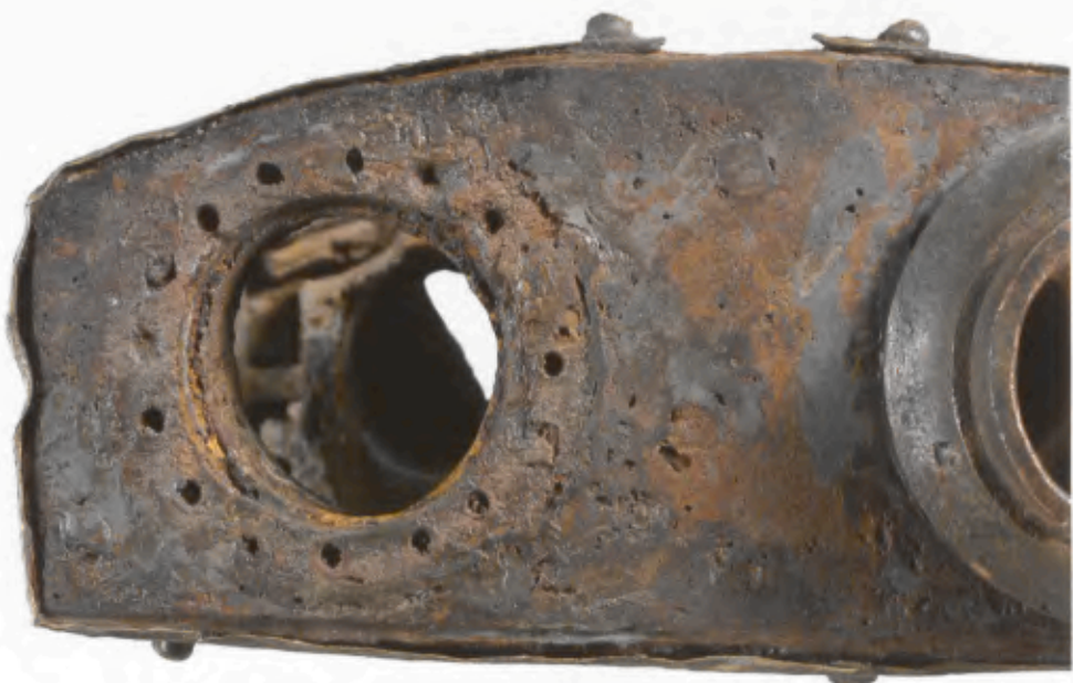
70 Querträger 3 nach Abnahme von Spannbuchse D und Entfernung des Korrosionsbelags von Gegenplatte 3.2.
