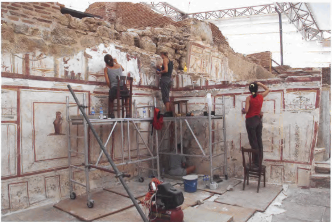
16 Restaurierung der Wandmalerei im sog. Musenzimmer der Wohneinheit 3.
