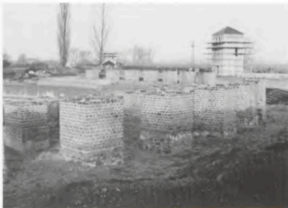
7 Die auf den originalen Fundamenten aufgemauerten Pfeiler des Amphitheaters.
