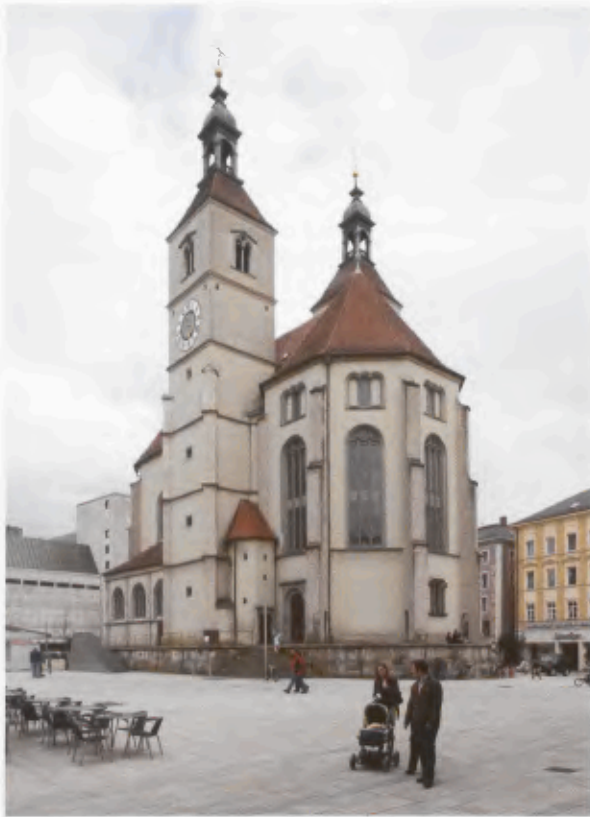
2 Regensburg, Neupfarrplatz. Links unten am Kirchensockel der rampenförmige Abgang zu den Schauräumen des „document Neupfarrplatz“. Blick nach Südosten.
