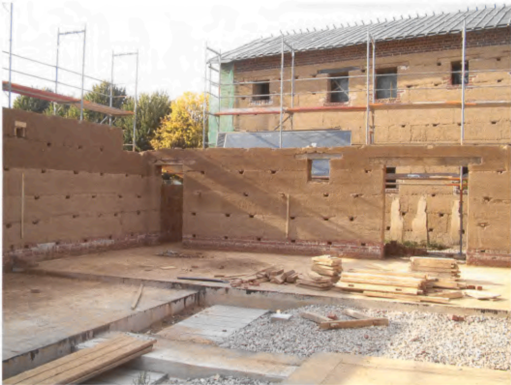
10 Lehmstampfmauern im Schuppen von Haus A. Die dunklen Partien wurden vor kurzem ausgeschalt. Die helleren Partien trocknen schon länger.
