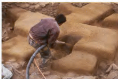
8 Frühhelladischer Rundbau, Blick von Nordost nach Freilegung 1998, Aufspritzen der wasserresistenten Lehm-schichten, Ergebnis, Verdeutlichung der Mauerkontur, 2004.
