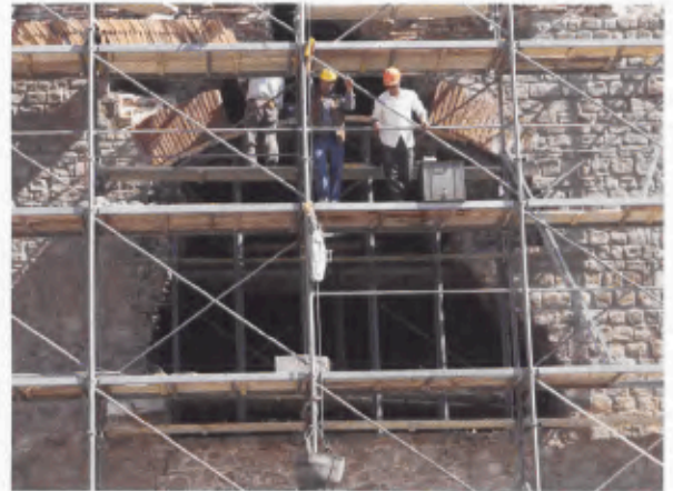
25 Die Einwölbung des Bogens aus rekonstruierten Ziegeln bipedalen Formats (2007).
