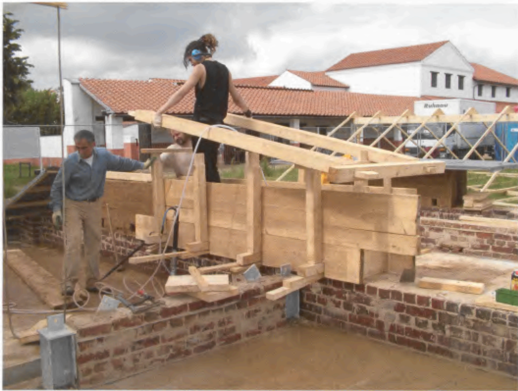
9 Aufbau des Schalungskastens für Lehmstampfwände im Haus A.
