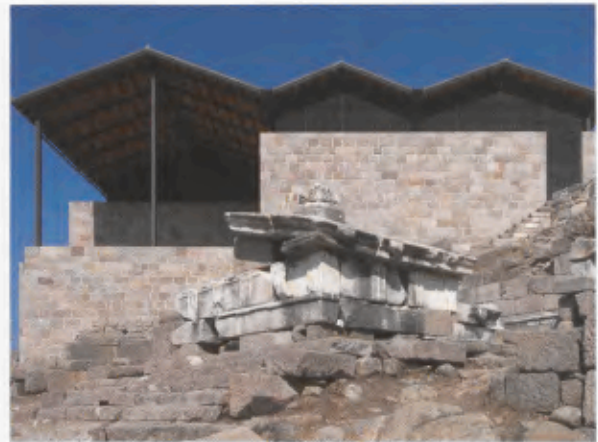
9 Der Eingangsbereich des Schutzgebäudes mit der Zäsur zwischen den Satteldächern und den rekonstruierten Mauerkronen (2004).
