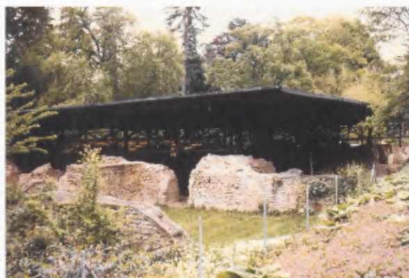
11 Badenweiler. Römische Badruine, Südwestansicht. Das 1953 errichtete Schutzdach auf eingespannten Stahlstützen mit nachträglich eingefügter Aussteifung.
