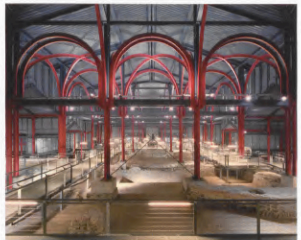
4 Schutzbau über den Großen Thermen der Colonia Ulpia Traiana . Ausbildung der Stahlträger im Dachbereich von Tepidarium 1.
