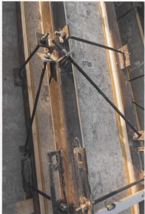
14 Transport von Winkelstählen (li.) und montiertes Stahlkorsett (re.).
