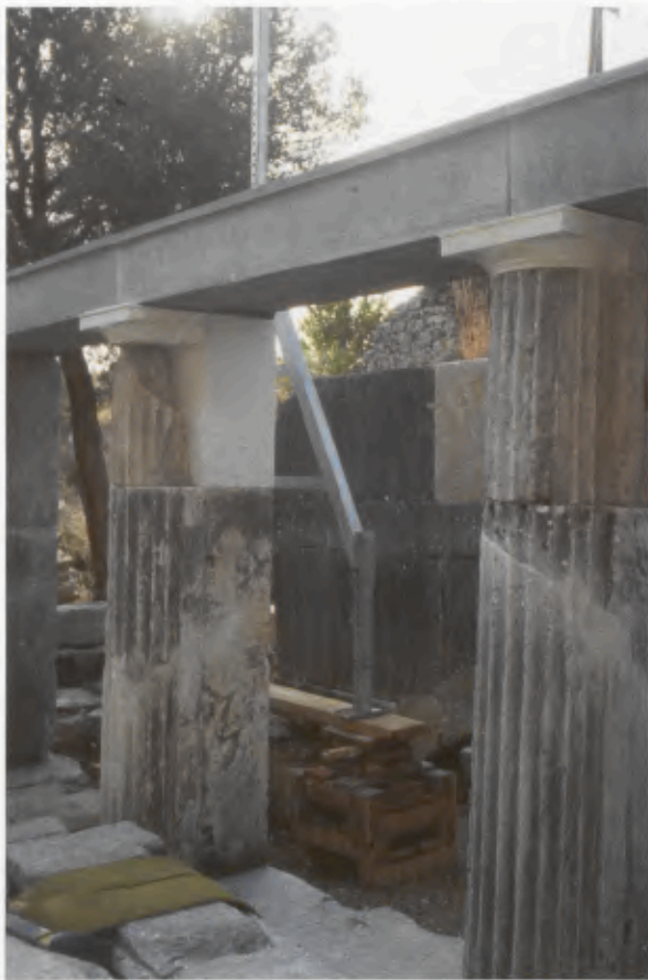
5 Proskenion. Halbsäulenpfeiler mit neuen Marmorkapiteln. Beton-Architrave.
