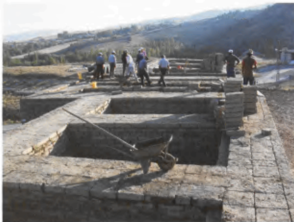
11 Aufmauern der Wände. Die Kästen wurden später mit Erde verfüllt.
