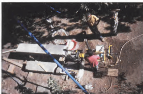
10 Querbalken. Bohrung in Längsrichtung.
