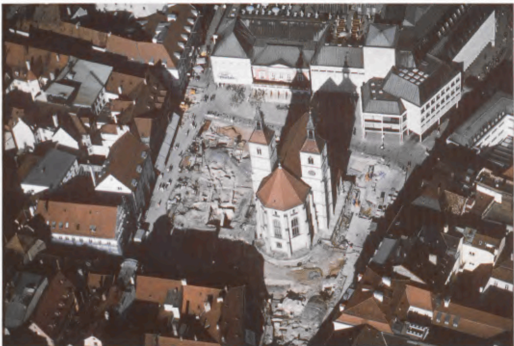
5 Der Neupfarrplatz im Jahr 1996 mit archäologischer Ausgrabung. Auf Höhe des linken Kirchturms sind die historischen Keller erkennbar, die heute im „document Neupfarrplatz“ präsentiert sind. Blick nach Osten.
