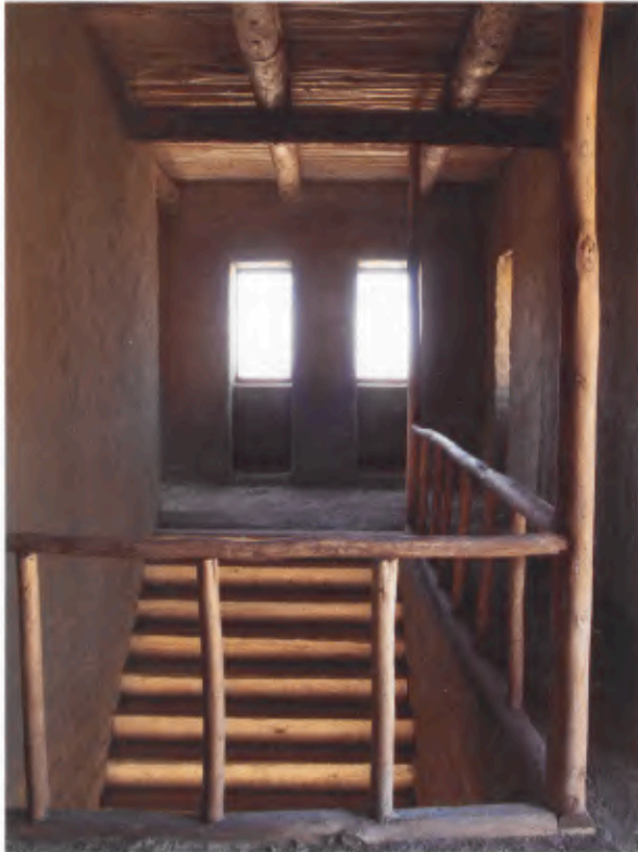
18 Der Aufstieg in den Nordturm erfolgt über eine Massivholztreppe.
