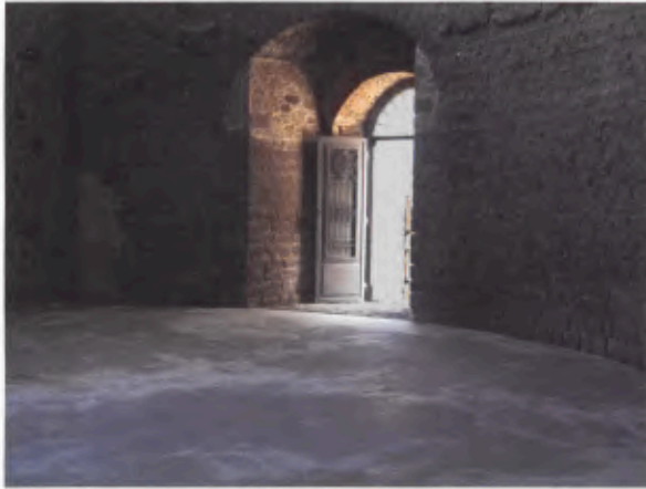
24 Die fertiggestellte neue Bodenplattform aus Stahlbeton im Inneren der Rotunde mit der Schattenfuge zum antiken Wandkörper (2008).
