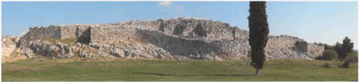
1 Oberburg Westseite, nach Konservierung von Treppenzugängen und Mauern.
