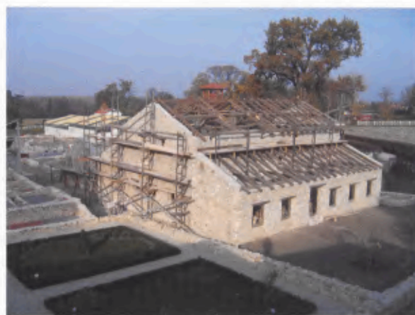
14 Steinmauerwerk mit Holzgerüsten und Dachstuhlkonstruktion mit handbearbeitetem Holz. Blick nach-Nordosten, 2005.
