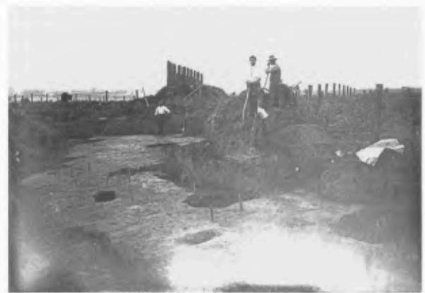
4 Blick von Nord-Westen auf die Rekonstruktion.
