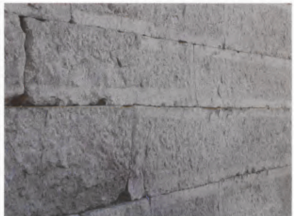
3 Extrem schmale Fugen und deren von der gespannten Schnur abweichender, leicht wellige Verlauf.
