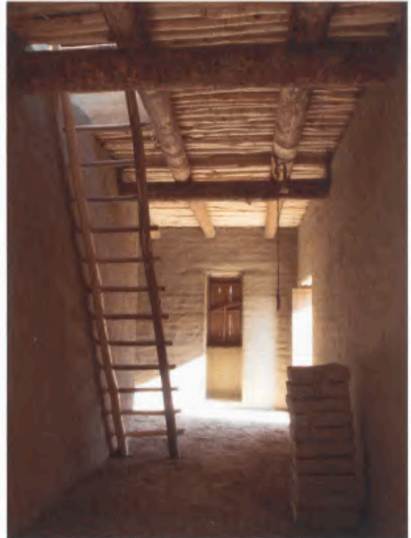
19 Über Leitern in den Turmgeschossen sind die Dächer zu erreichen.
