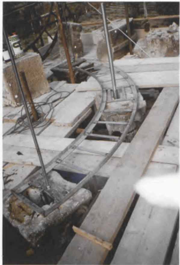
22 Pompeji, Mausoleum der Istacidier, obere Ordnung, Stahlgerüst für den Architrav.
