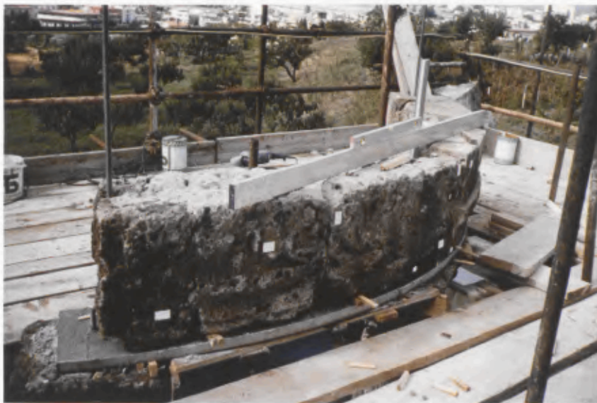
23 Pompeji, Mausoleum der Istacidier, Anastylose der Architravblöcke.
