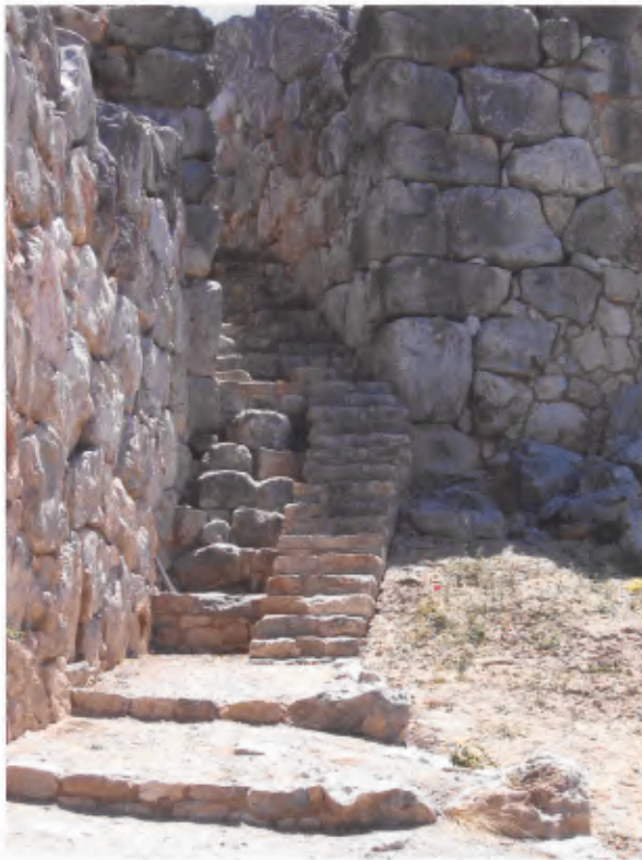
11 Treppenaufgang durch Westpforte, Zustand nach Stabilisierung, 2004.
