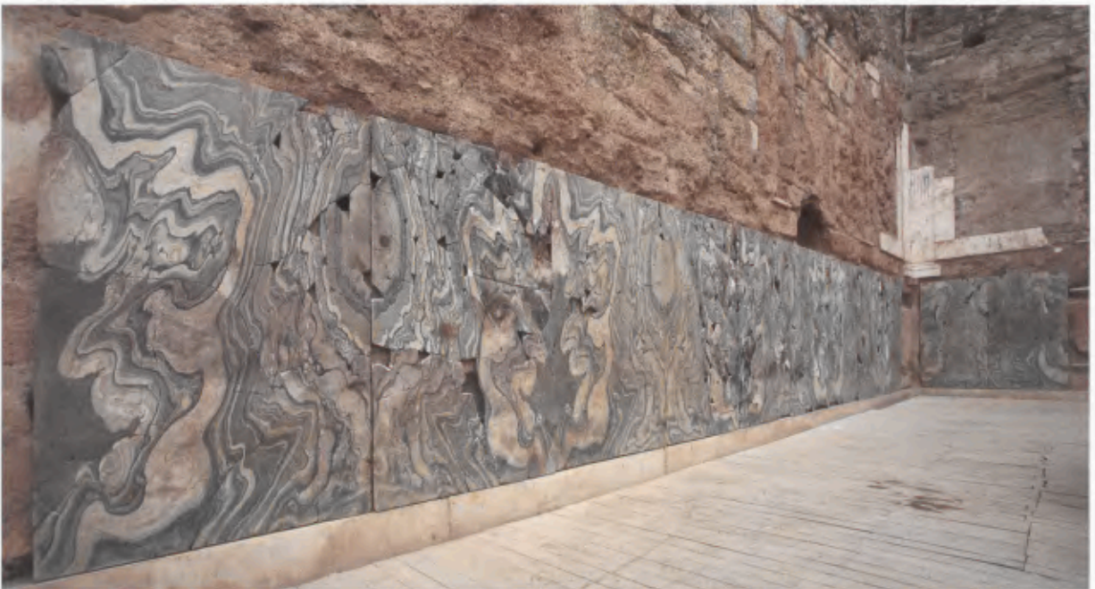
28 Wiederapplizierte Sockelzone auf reversiblen Schienensystem.
