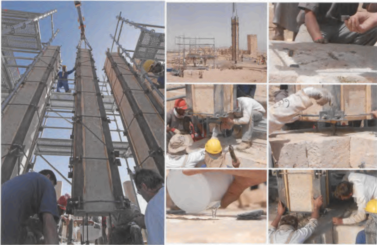
18 Der endgültige Versatz der sanierten Pfeiler mit dem Kran.
