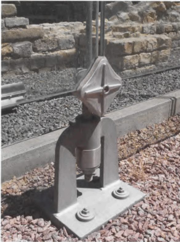
18 Badenweiler. Schutzbau, Befestigungsdetails der Spannseile der westlichen Glasfassade, (li) auf Streifenfundament, (re) am T-Träger.
