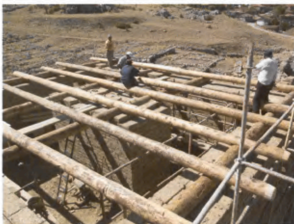
13 Rost aus Holzstämmen, der als oberer Ringanker und als Trägerkonstruktion für die Dachdeckung im Nordturm dient.
