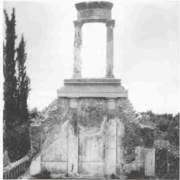
17 Pompeji, Mausoleum der Istacidier, Ansicht nach der ersten Restaurierung durch Amedeo Maiuri 1934.
