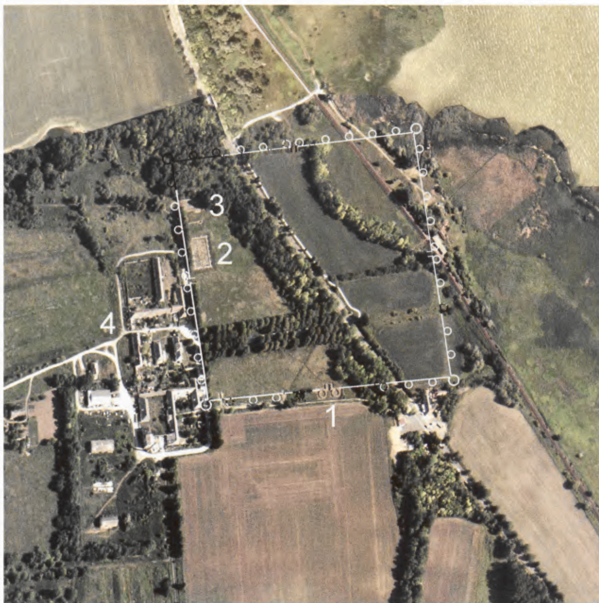
12 Die heute sichtbaren Denkmäler in Keszthely-Fenépuszta mit dem rekonstruierten Grundriss der spätrömischen Befestigung (4. Jh.): Südtor der Festung (1), horreum (2), frühchristliche Basilika (3), und Festetics-Gebäudekomplex des 18.–19. Jahrhunderts (4).
