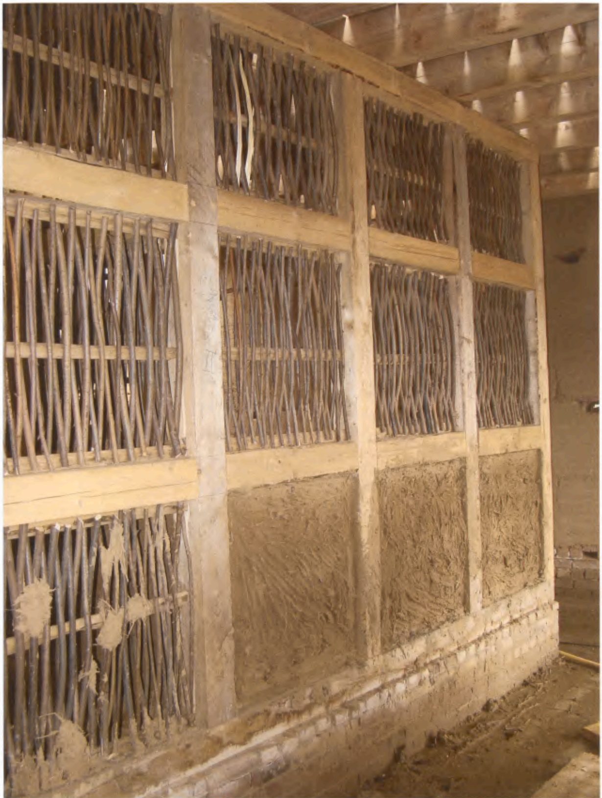
13 Fachwerkzwischenwand im Haus C im Bauzustand.
