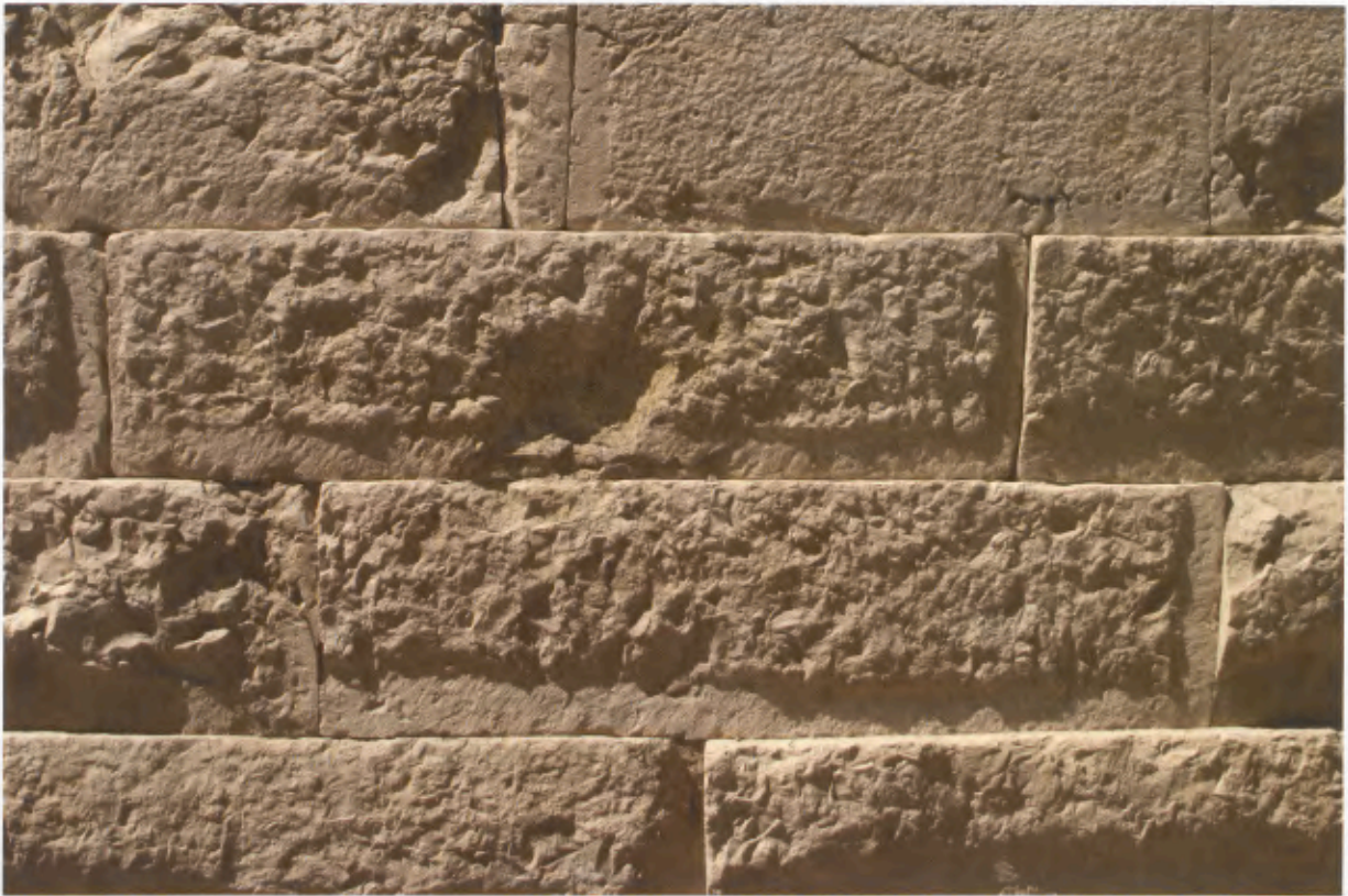
5 im Fundamentbereich erhalten gebliebene Randschläge an der Unterkante und der rechten Stoßfuge der Blöcke.
