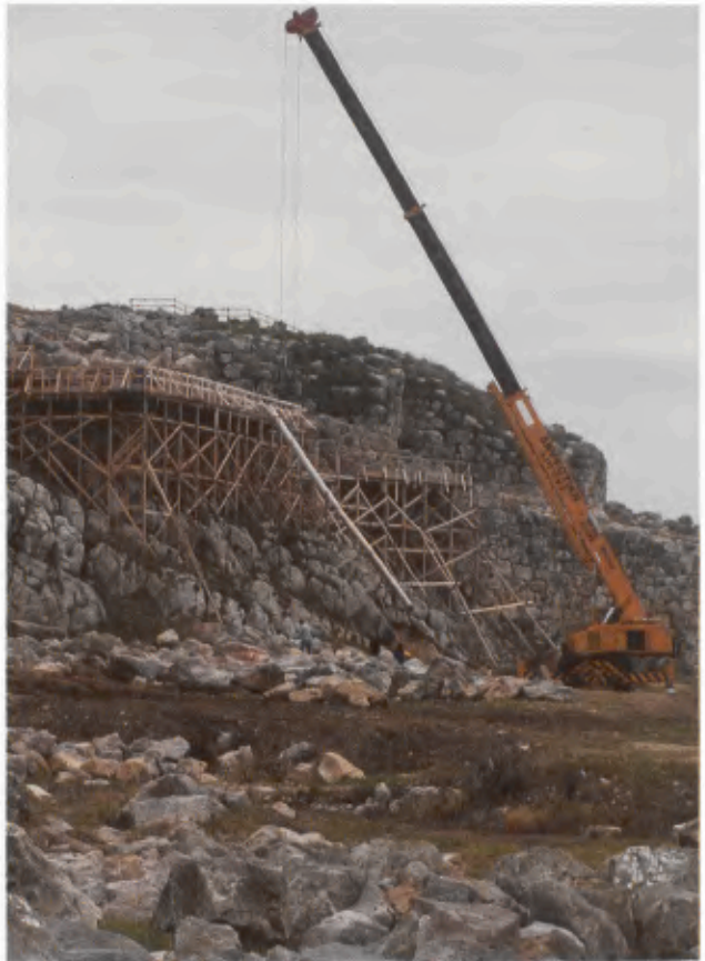
10 Westtreppe aus Vogelperspektive, nach Stabilisierung und Teilrekonstruktion, 2001. Einsatz Mobilkran zum Steinversatz, Arbeitsgerüst an Westtreppe und Turm.
