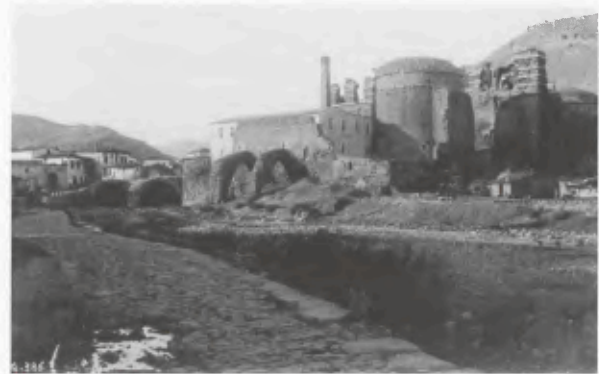
15 Die Rote Halle mit den hoch aufragenden Einbauten der Olivenölfabrik (um 1910).
