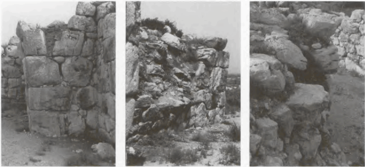
4 Schäden am Palastmauerwerk, Korridor Ost Oberburg, Zustand 1992.
