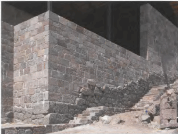
8 Differenzierung zwischen den ergänzten Partien und dem Originalbestand der östlichen Abschlusswand von Bau Z (2004).
