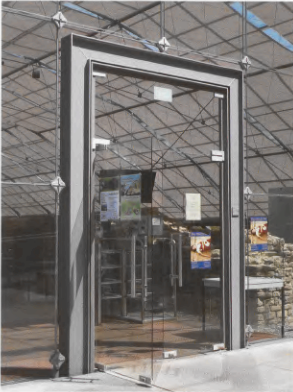
16 Badenweiler. Eingangstür in den Schutzbau, Drehkreuz für den Eintritt der Besucher und im Hintergrund der hochgezogene Sonnenschutz unter dem Stahl-Glas-Gewölbe.
