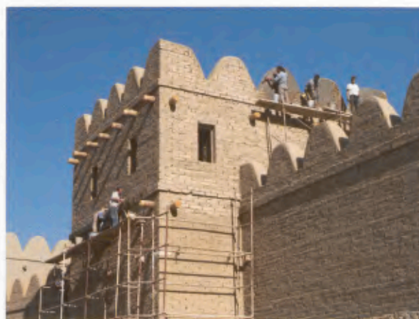
15 Aufbringen des Verputzes am Südturm.
