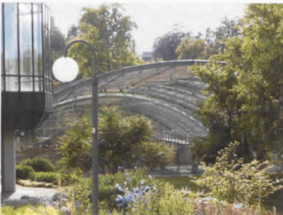
20 Badenweiler. Blick von Osten in den Kurpark und den neuen Schutzbau der römischen Badruine, 2009.
