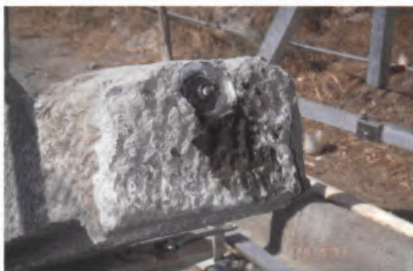
11 Querbalken. Verschraubte Bewehrungsstange.
