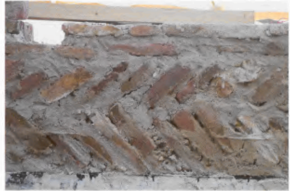
8 Rekonstruiertes Fischgrätmauerwerk im Haus B im Bauzustand.
