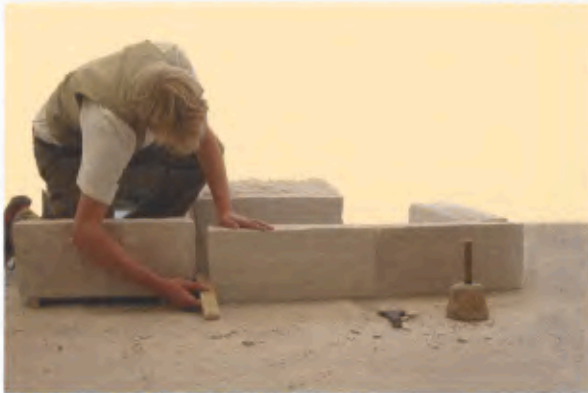
11 Anreißen des auf Rollen platzierten Quaders auf dem im Steinbruch vorgefertigten Stoßfugenschlag mittels Reißnadel und Abstandholz.
