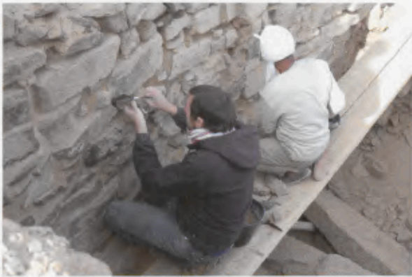
5 Tayma, Saudi-Arabien. Sicherung der Mauerfugen des Bruchsteinmauerwerks unmittelbar nach der Ausgrabung.
