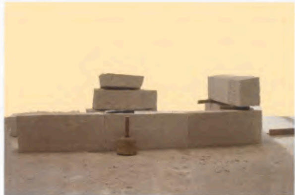
12 Transport des Eckquaders auf Rollen; die rückseitige Sandschüttung zur Schaffung einer Arbeitsebene wurde hier zur besseren Übersicht weggelassen.
