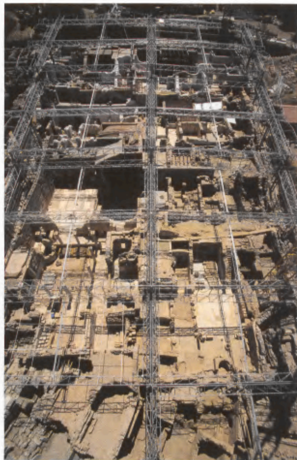
12 Edelstahlkonstruktion des aktuellen Schutzdaches über dem Hanghaus 2.
