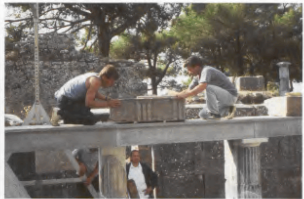
6 Proskenion. Rollen eines Triglyphenblockes.
