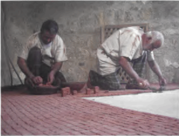
15 Verlegung des Ziegelmosaikbodens im Bereich der Südveranda, 2006.
