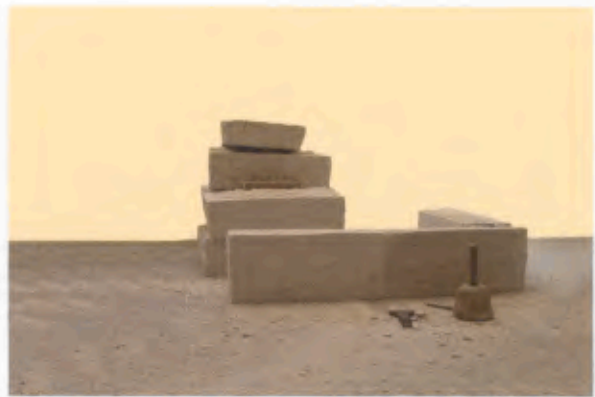
10 Situation nach Versetzen.
