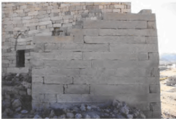
1 Wandabschnitt einer Bebauung in Sirwäh, gut erkennbar sind die großen Längen der verwendeten Blöcke.
