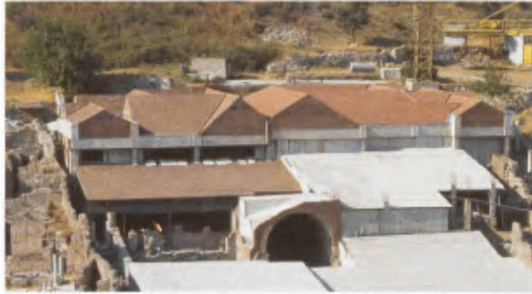
8 Schutzdach über den Wohneinheiten 1 und 2.
