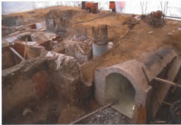
11 Einbau des Tragwerks aus Betonbohrpfählen neben den mittelalterlichen Kellern. Die Betonröhre des Bunkers ist bereits aufgeschnitten.
