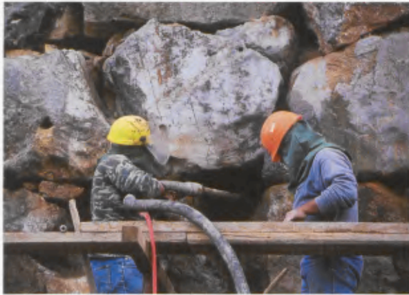
12 Arbeiten zur Stabilisierung des zyklischen Mauerwerks, 2003: Einspritzen von Erd-/Lehmmasse unter Hochdruck in Kavernen, Einsetzen von Füllsteinen zum Schließen der Außenfugen mit Mörtel.
