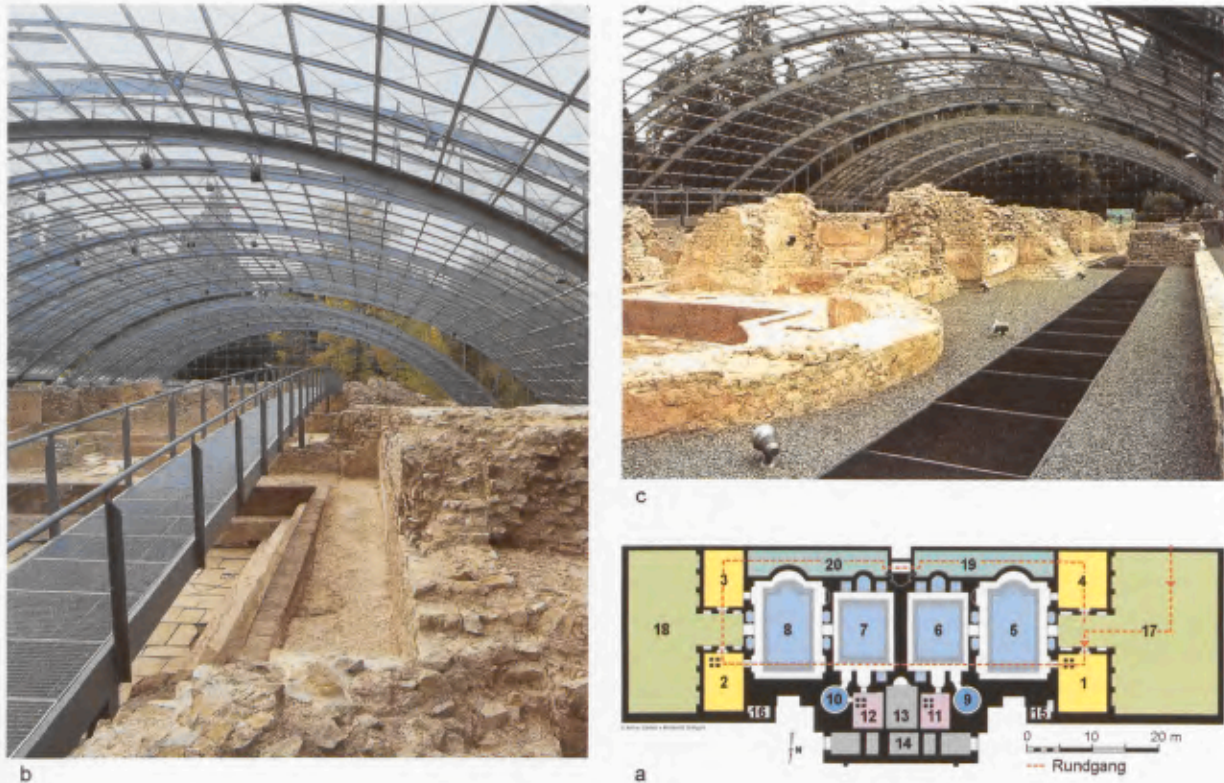
19 Besucherrundgang im neuen Schutzbau: (a) Übersicht, (b) die ca. 52 m lange Bogenbrücke, deren höchster Punkt einen hervorragenden Überblick über die gesamte Ruine gewährt, (c) Rückweg entlang der erhaltenen Südfassade der Badruine.
