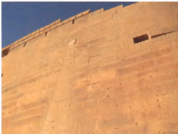
2 Außenmauer des Almaqahtempels von Sirwäh.
