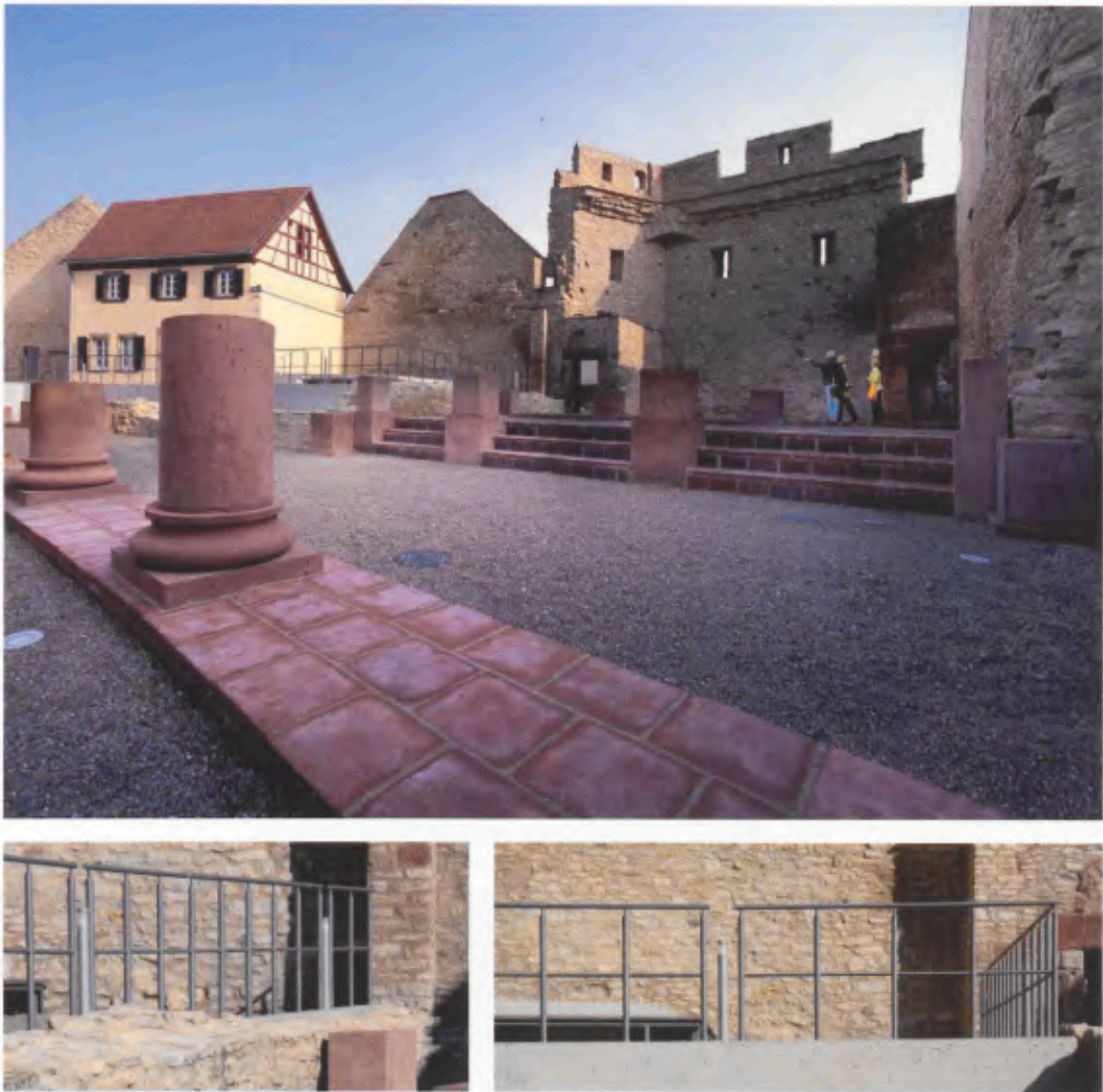
6a–b Heidesheimer Tor: a (o.) Ansicht des archäologischen Präsentationsbereichs. b (u.) Beispiele für die konzeptgerechte Mauerwerksbehandlung mit Verschleißschicht und Bleibandeinlage.
