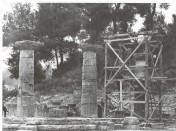
4 Rekonstruktion einer Säule des Heraions, 1972.
