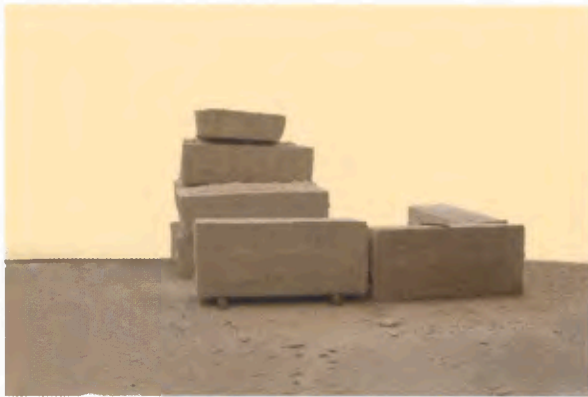
9 Platzieren eines Quaders auf Rollen.
