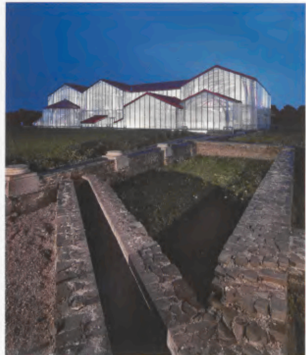
2 Schutzbau über den Großen Thermen der Colonia Ulpia Traiana von Süden.
