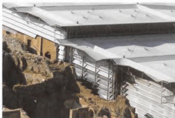
13 Lamellenförmige Fassade des Schutzdaches.
