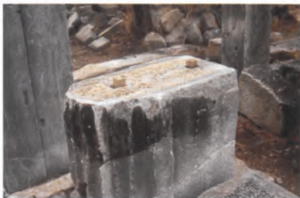
8 Proskenion. Halbsäulenpfeiler, geklebt und mit neuen Messingdübeln in den alten Löchern.
