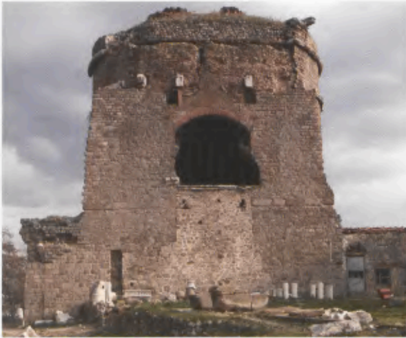
17 Die Westfassade des südlichen Rundturms vor Beginn der Restaurierungsarbeiten (2005).
