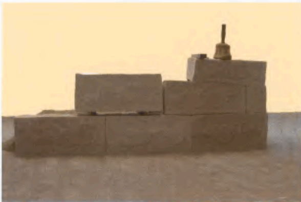
17 Der nächste Quader befindet sich in der zum Anzeichnen idealen Position, im Hintergrund ist das Sandlager zur Schaffung einer Arbeitsebene erkennbar.
