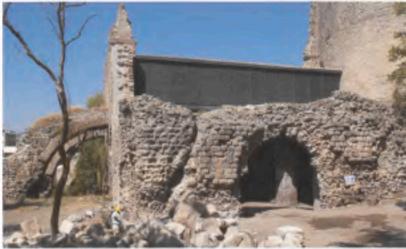
20 Das neue Depotgebäude, das anstelle des Wächterhauses errichtet wurde, mit der durch Stahllamellen geschlossenen Ostfassade (2007).
