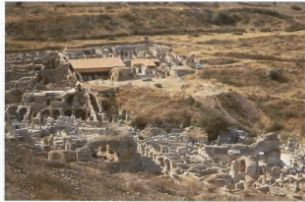
7 Erste – provisorische – Schutzdachlösung über dem Hanghaus 2.
