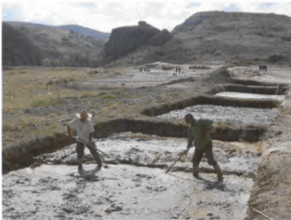
9 Das Mischen von Lehm, Stroh und Wasser in großen Gruben geschah ausschließlich per Hand und Fuß.
