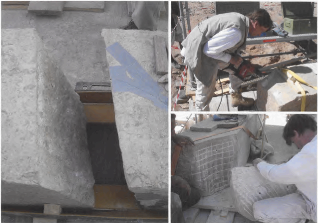
16 Sanierung der Pfeiler im liegenden Zustand.
