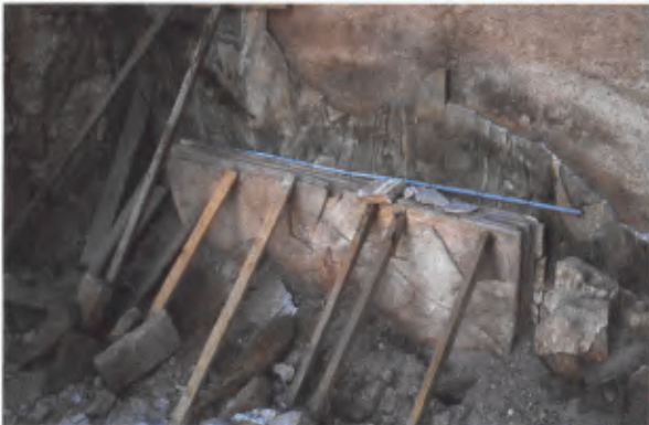
25 Zur Wiederverlegung vorbereitete Wandverkleidungsplatten an den Wänden gestapelt.
