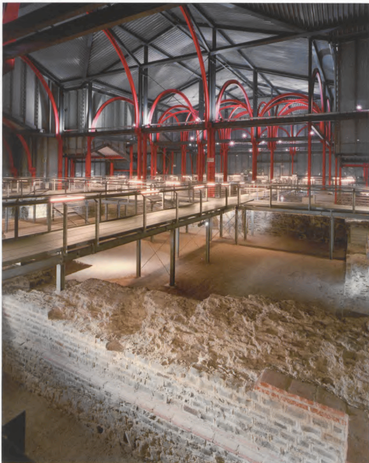
5 Schutzbau über den Großen Thermen der Colonia Ulpia Traiana . Inneres Stützensystem und Besuchersteg.
