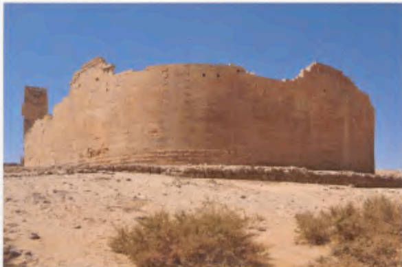
4 Umfassungsmauer des Almaqah-Tempels von Sirwah von Osten.
