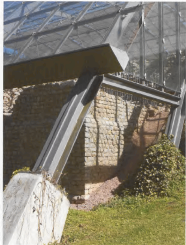
17 Badenweiler. Betonabschluss der Pfahlgründung für einen über 40 m spannenden T-Träger des Schutzbaus.
