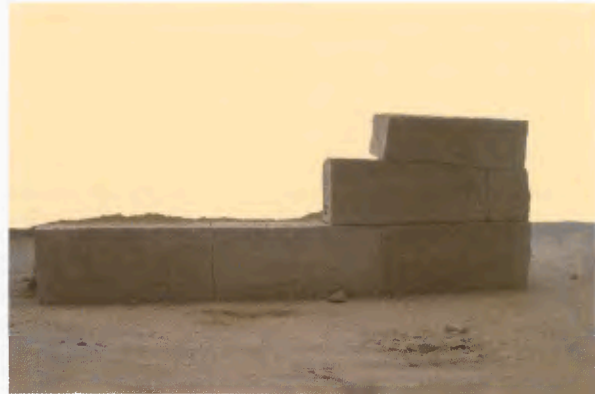
16 Am bewusst wellig angelegten Verlauf der Lagerfuge erkennt man die Tauglichkeit des Verfahrens, extrem schmale Fugen ohne Schablonen herstellen zu können.
