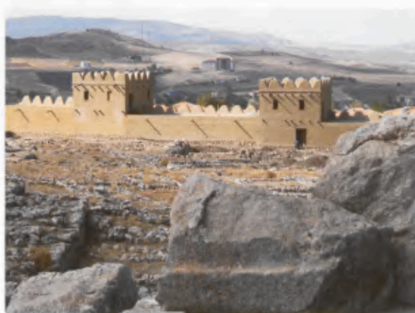
17 Die Entwässerung der Dachflächen erfolgt auf der Mauerrückseite über Wasserspeier, die aus halbierten Holzstämmen gearbeitet sind.
