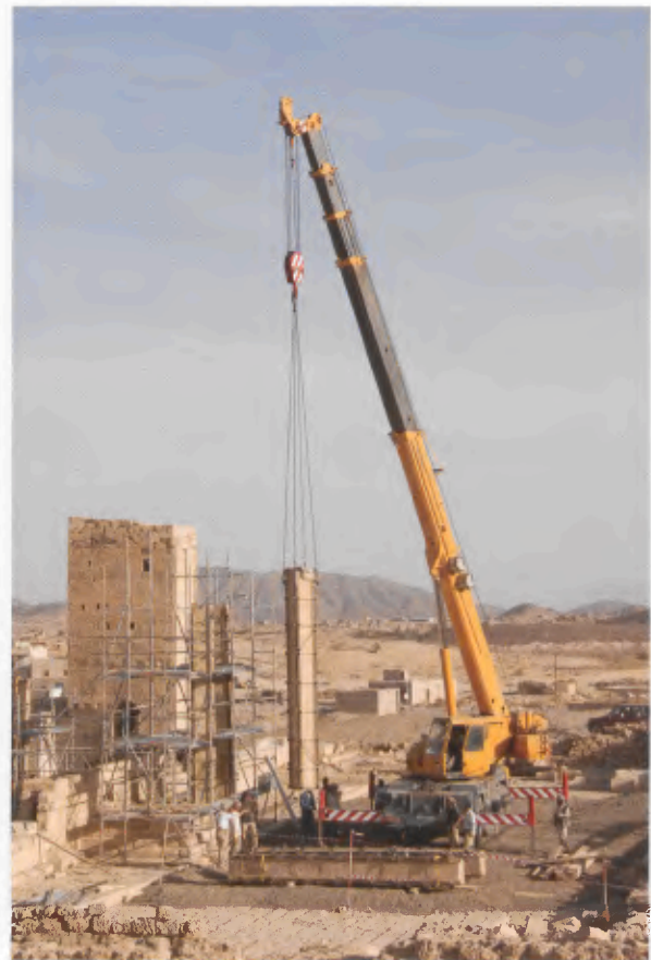
15 Transport eines Pfeilers des Inneren Propylons mit dem Kran.
