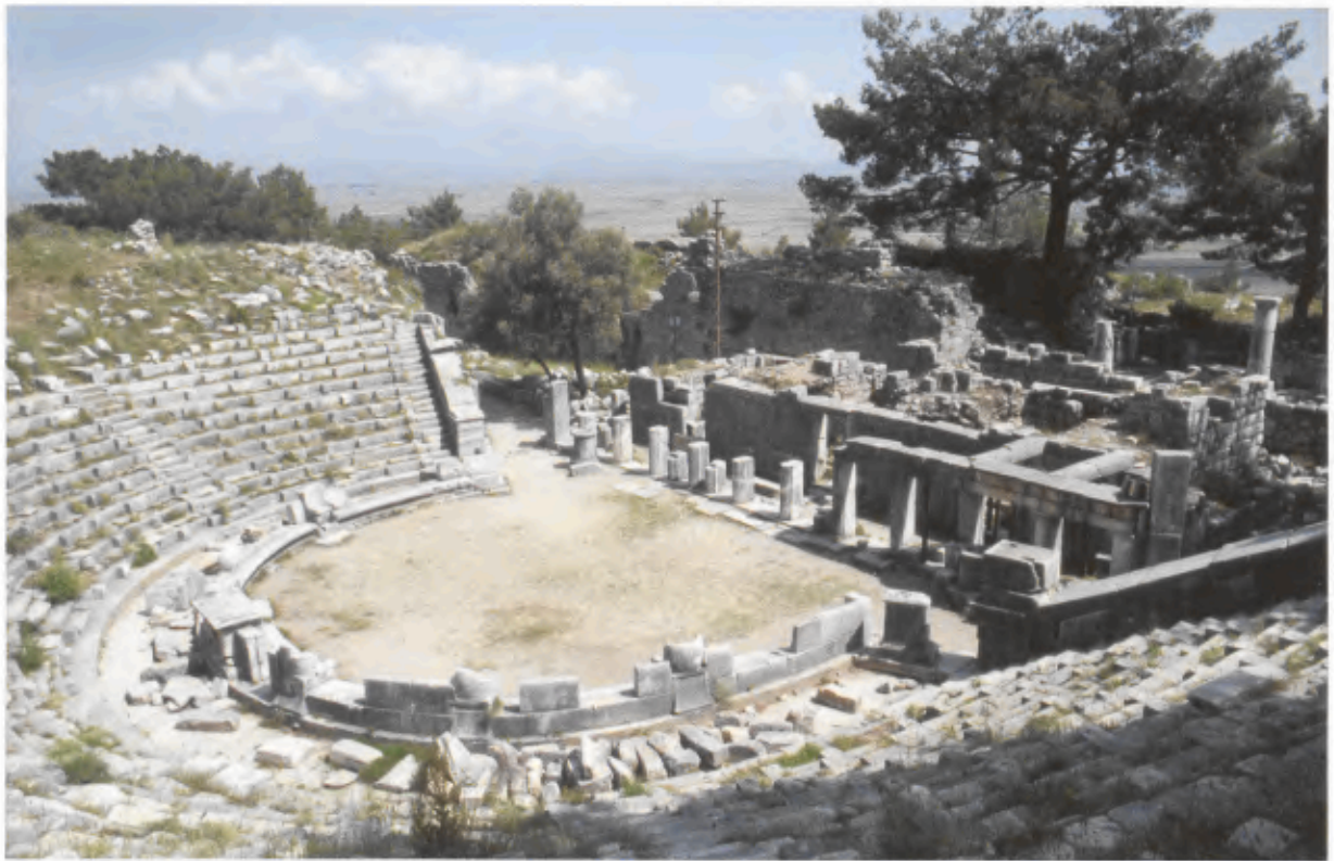
4 Theater, Zustand 1993, Pfeiler bereits geklebt.
