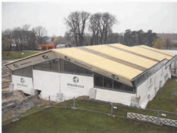
18 Stahlhallen-Schutzbau über dem „Peristylhaus“ des Freilichtmuseums. Blick nach Norden, 2004.
