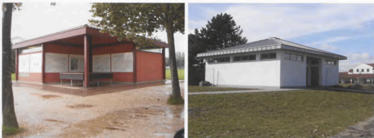
21 Bauform, Baumaterial und Farbgebung der alten Sanitäranlage setzten diese für den Laien nicht deutlich von den Rekonstruktionen im LVR-APX ab (links). Die neuen Infrastrukturgebäude (rechts) folgen einer klar differenzierten Architektursprache.
