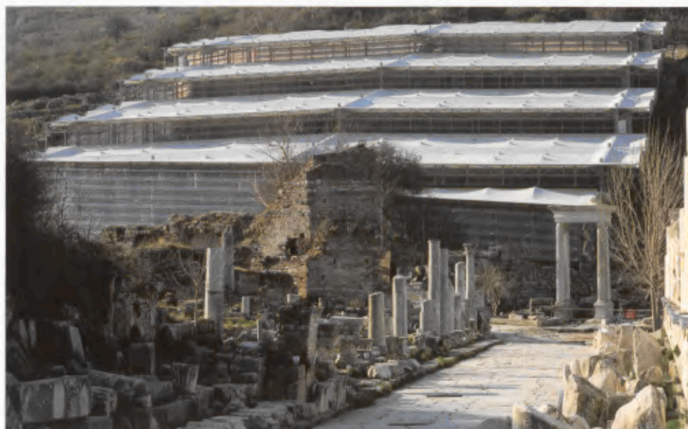
14 Das Schutzdach von Norden aus gesehen.
