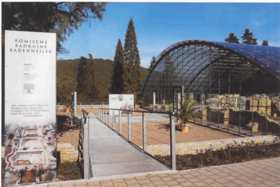
15 Badenweiler. Blick von Südwesten auf die Eingangsterrasse vor dem Schutzbau.
