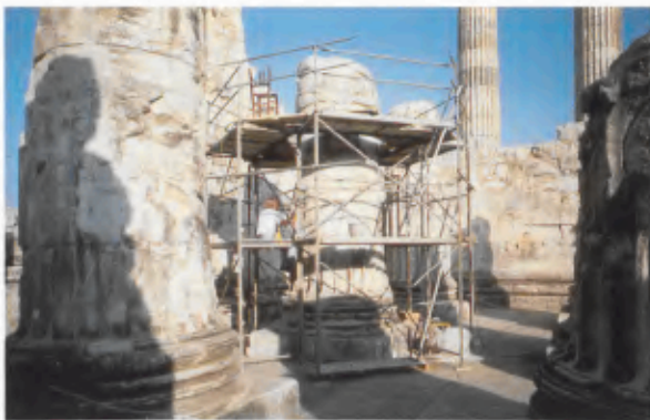
8 Didyma, Türkei. Konsolidierung der Marmorteile des Apollontempels.
