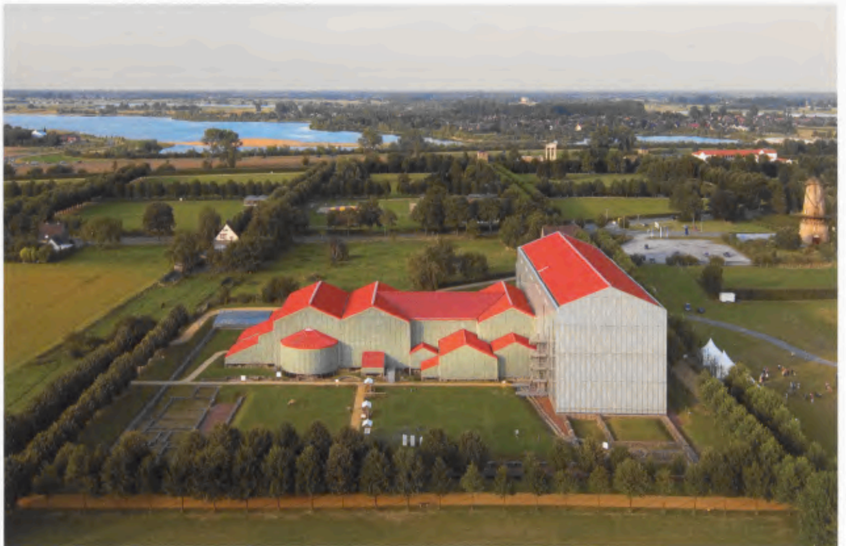
15 Die Großen Thermen Xanten. Vor dem Schutzbau sind die Fundamente durch Aufmauerungen sichtbar gemacht worden.
