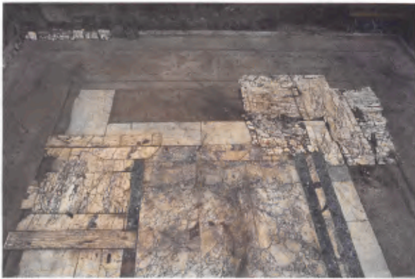
24 Zur Wiederverlegung vorbereitete Wandverkleidungsplatten auf dem Boden des Marmorsaals.
