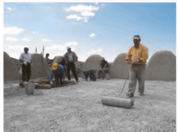
14 Auf den Dachflächen wird eine dicke Lage Serpentinigrus als Isolierung auf dem Lehmestrich ausgebracht und sorgfältig durch Walzen verdichtet.
