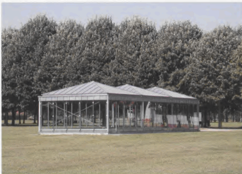
17 Schutzbau über dem Befund eines römischen Wohn- und Gewerbehäuses.
