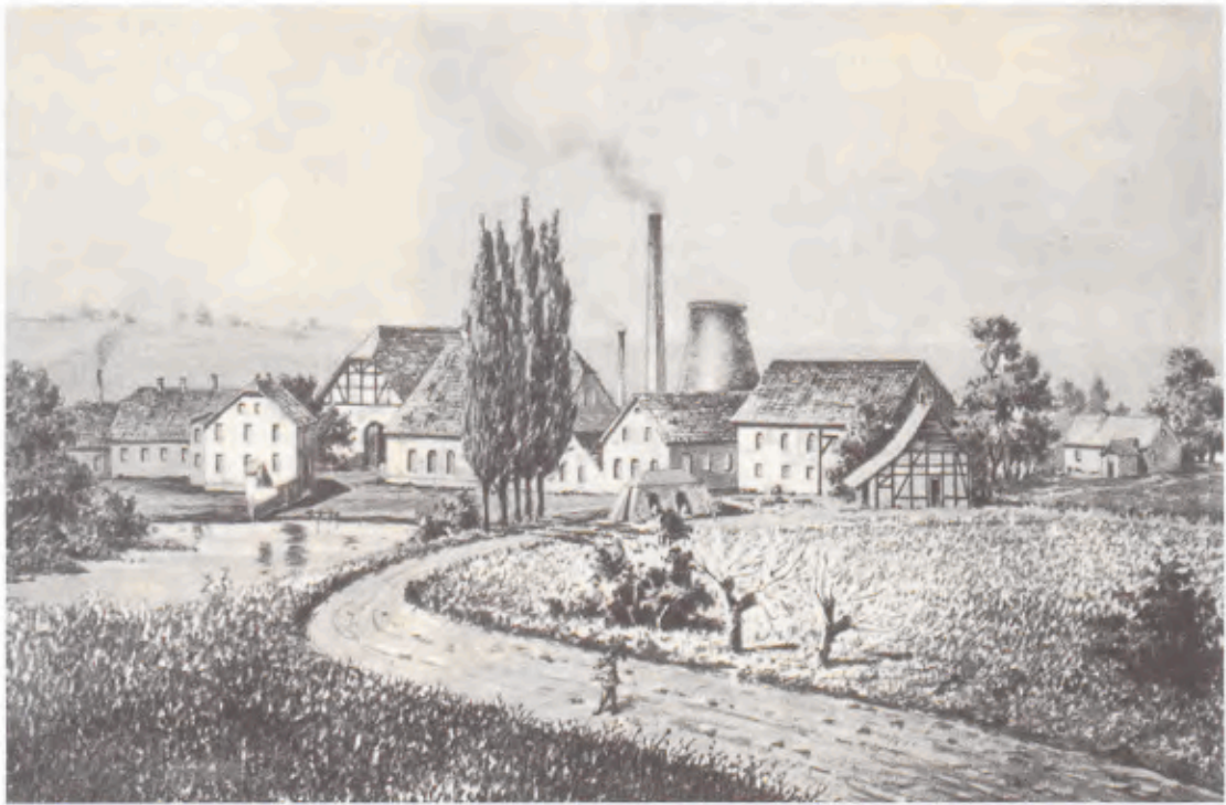
1 Ansicht der St. Antony-Hütte um 1850, Gemälde von Jakob Weeser-Krell, 1902. Links das erhaltene Wohnhaus am Hüttenteich gelegen, daneben die Gießerei- und rechts die Lehmformereigebäude, dahinter mittig Schornsteine der Hütte und ein schlesischer Kokshochofen.
