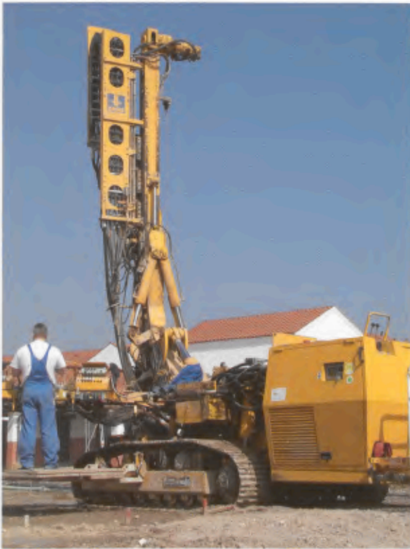
6 Bohrgerät für die Bohrpfahlgründung auf der Baustelle von Haus A.
