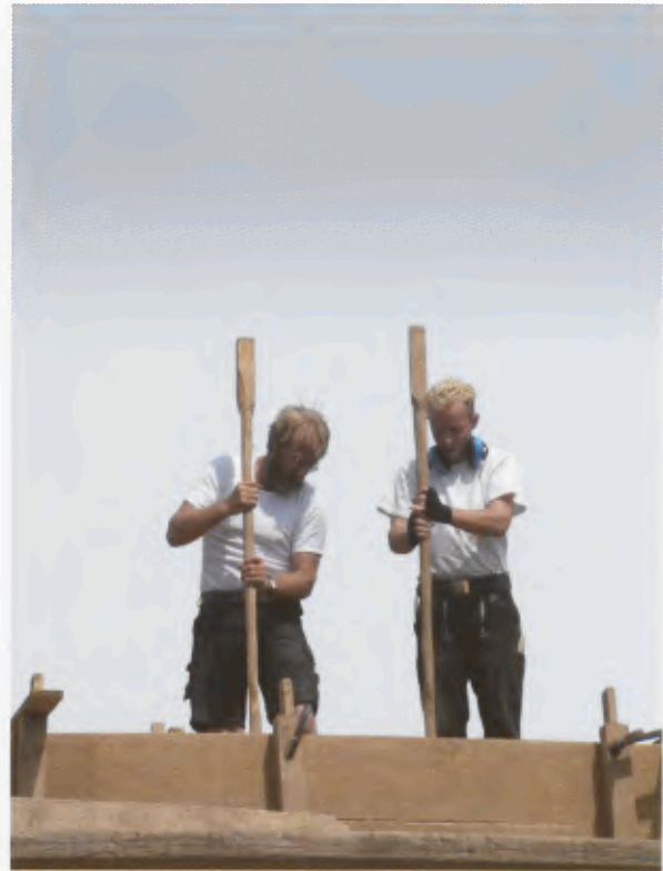
11 Stampfen eines Blocks mit Handstampfern als Versuch.
