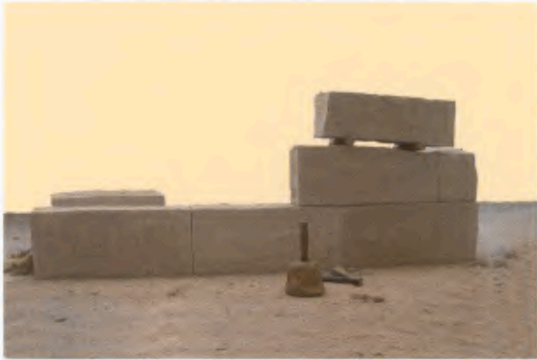
15 Der in Abb. 14 erkennbare Höhenunterschied der Quader wurde egalisiert, der Quader aus Reihe drei wird transportiert.
