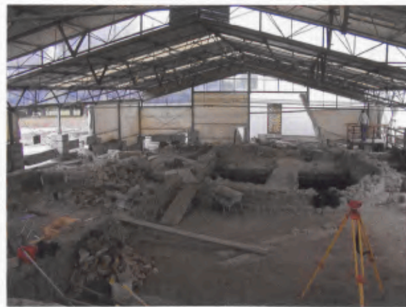
19 Stahlhallen – Schutzbau über dem „Peristylhaus“ des Freilichtmuseums im Inneren. Blick nach Norden, 2006.
