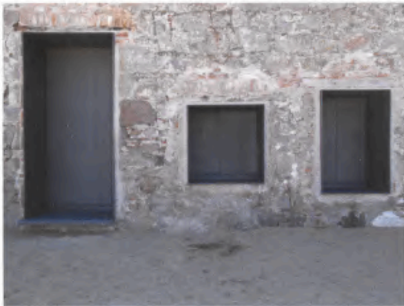
21 Die Bruchsteinwand der alten Ölfabrik mit den neuen Fensterelementen des Depots aus Stahl (2009).
