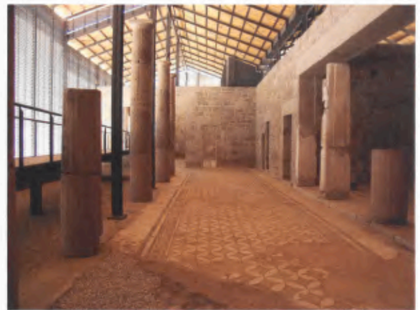
12 Pergamon, Türkei. Schutzbau über Bau Z. Nur mit einem Schutzbau waren die gut erhaltenen Mosaikböden zu schützen und der Öffentlichkeit zu präsentieren.
