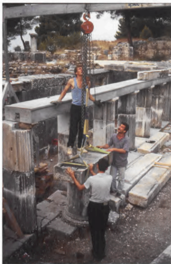
12 Proskenion. Heben eines Trilyphenblockes.
