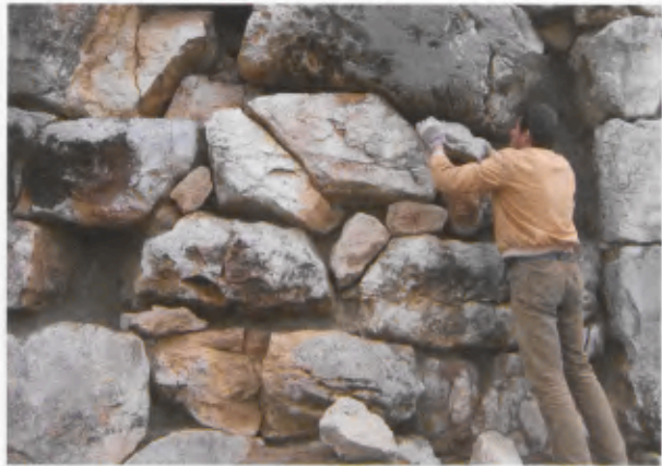
12 Arbeiten zur Stabilisierung des zyklischen Mauerwerks, 2003: Einspritzen von Erd-/Lehmmasse unter Hochdruck in Kavernen, Einsetzen von Füllsteinen zum Schließen der Außenfugen mit Mörtel.
