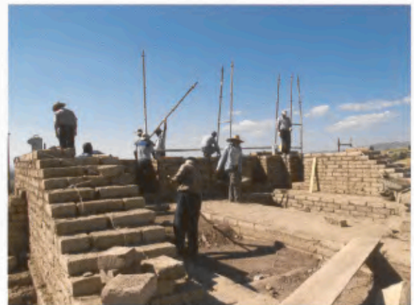
12 Aufmauern der Wände des Obergeschosses des Nordturms.
