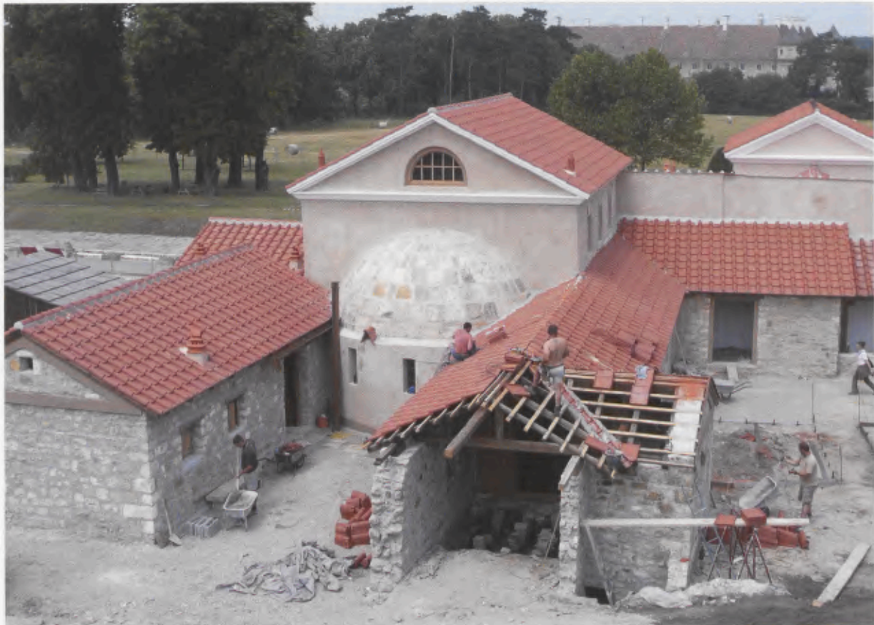
21 Modellhafte Rekonstruktion einer römischen villa urbana mit Gartenanlage im antiken Wohnstadtviertel südlich von Schloss Petronell. Das Gebäude wurde funktionstüchtig in antiker Handwerkstechnik errichtet. Blick nach Nordosten, 2008.
