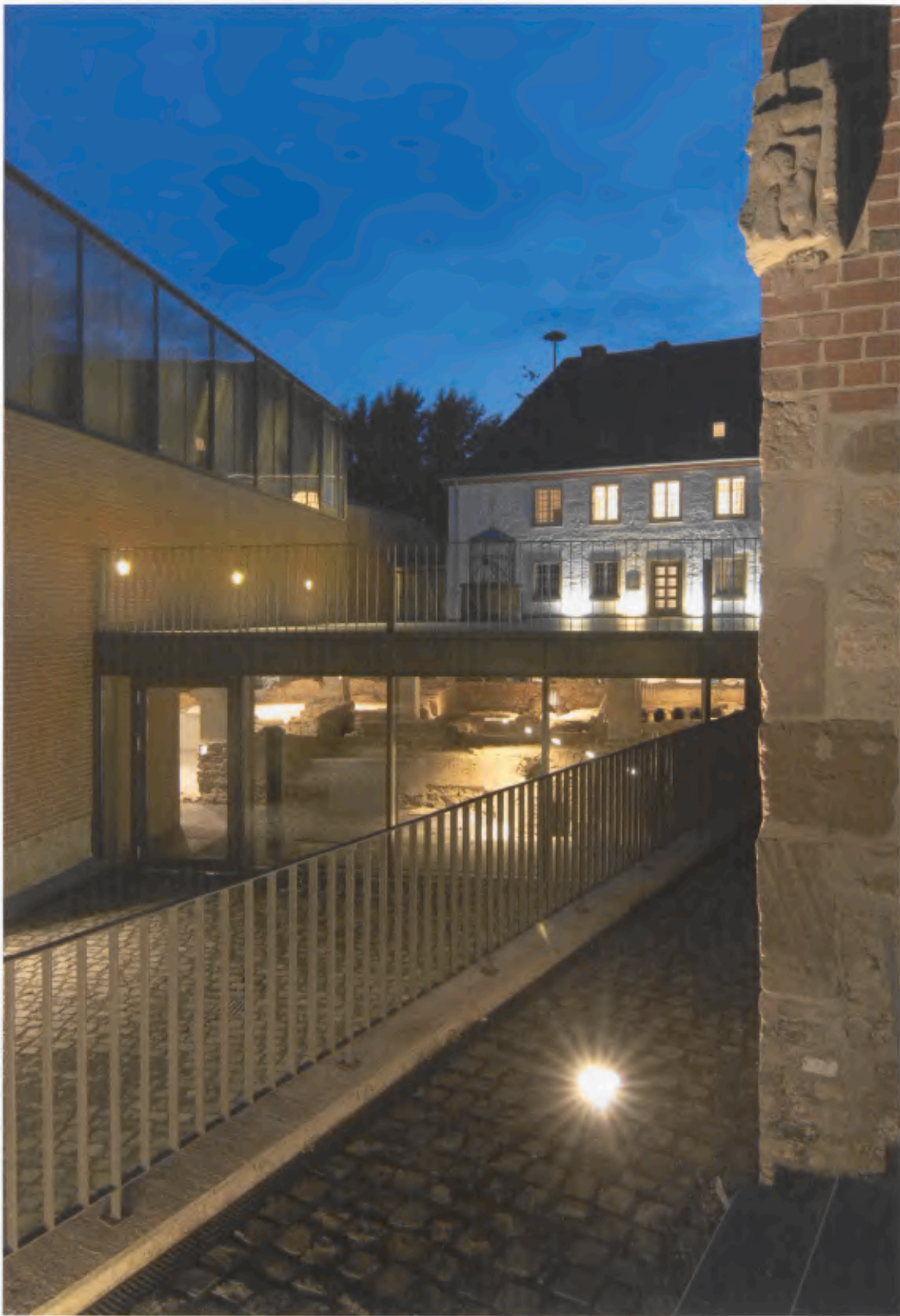
14 Blick auf die beleuchtete Thermenanlage von Zülpich mit „aufsitzendem“ Quirinusplatz; links der Museumsneubau, hinten der Altbau (Propstei-Haus).
