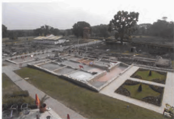
10 Denkmalpflegerische Gestaltung eines römischen Wohnhauses mit wiederhergestelltem Garten, Teilrekonstruktion von Mauerwerk und einem Strukturgerüst zur Andeutung der dritten Dimension. Blick nach Nordosten, 2003.
