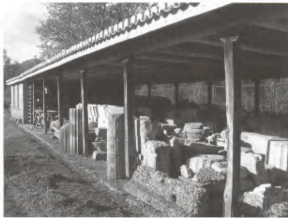
12 Schutzbau für Architekturteile im östlichen Steinlager, 2007.
