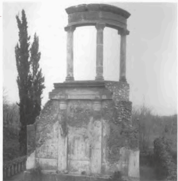
18 Pompeji, Mausoleum der Istacidier, Ansicht nach der definitiven Restaurierung durch Amedeo Maiuri 1935.
