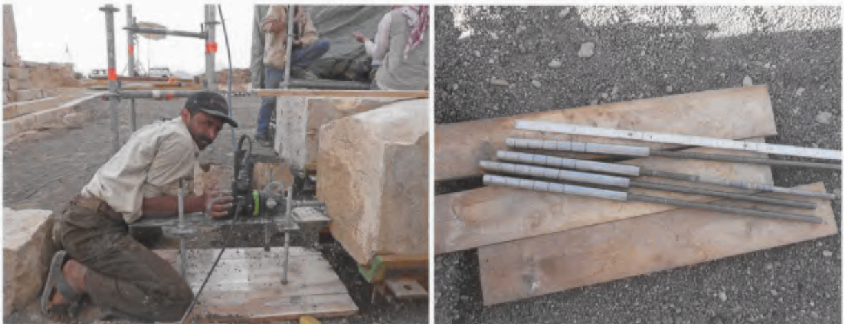
17 Das Bohren der Löcher für die Edelstahlverankerungen in die Pfeiler unter Einsatz eines Bohrtisches.
