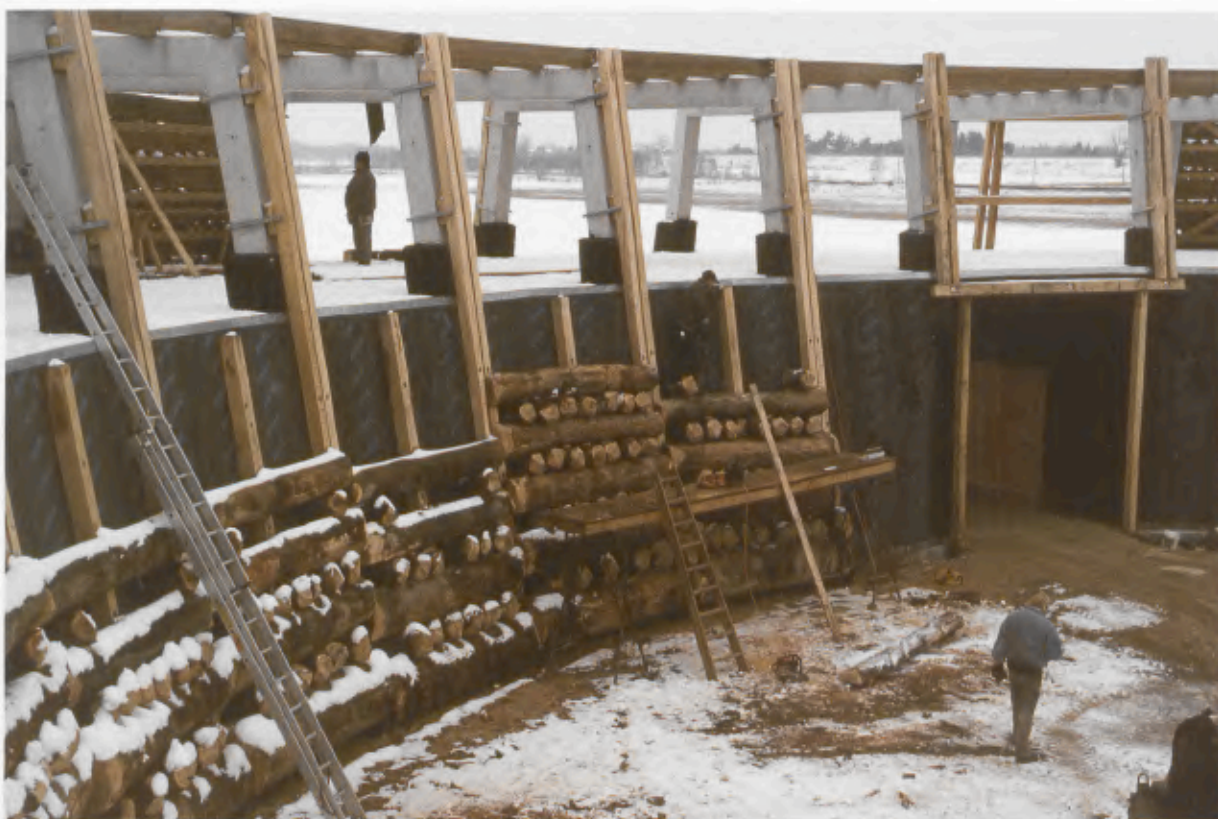
7 Aufsicht auf die untersten Rahmen eines Segments der Wallmauer. Die Kästen mit an Längs- und Schmalseiten durchgehenden Stämmen wurden im Inneren mit rostartig geschichteten kurzen Ästen, Sand, Erde und Lehm verfüllt. Ca. 40 solcher Segmente bildeten die Radduscher Wallmauer.
