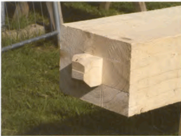
14 Holzzapfen mit vierseitiger Brust. Rekonstruktion Haus C.
