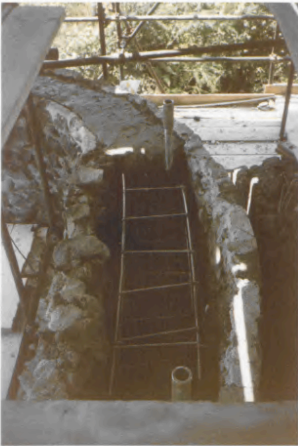
21 Pompeji, Mausoleum der Istacidier, obere Ordnung, Wiederherstellung des Unterbaus der Säulenstellung.
