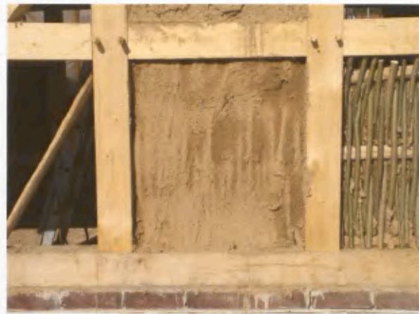
15 Ausfachung der Fachwerkwand mit senkrechten Rutengeflecht (rechts) und erstem Lehmbewurf (Mitte). Schuppen Haus A im Bauzustand.
