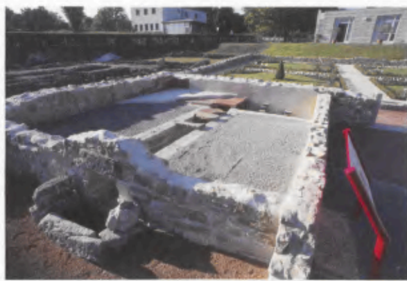
11 Teilrekonstruktion einer römischen Fußbodenheizung in Haus I. Blick nach Südosten, 2003.
