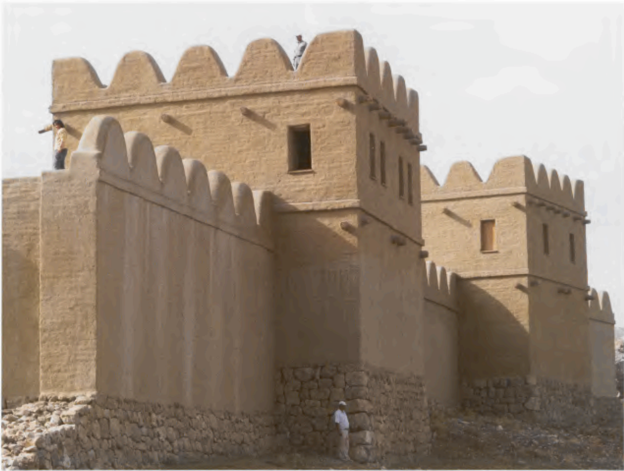
8 Rekonstruierter Abschnitt der Befestigungsmauer, Ansicht von Nord-Nordost.
