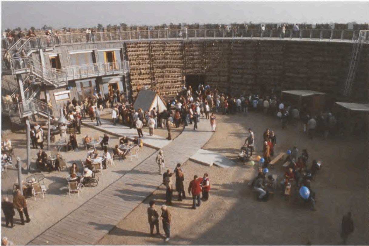
11 Der Burghof bleibt im Gegensatz zum Zustand in zu slawischer Zeit vorläufig frei von Bebauung, um Veranstaltungen zu ermöglichen. Im Bild links sind die modernen Bereiche im Innenhof zu erkennen. Der Treppenturm führt entsprechend der Sicherheitsauflagen auf die Wallkrone. Die Büros, Schulungs- und Tagungsräume und auch das Restaurant erhalten Tageslicht. Die Holzverblendung aus dem nachgewiesenen Originalbaustoff (Eiche) soll ganz bewusst deutliche Spuren moderner Technik zeigen.
