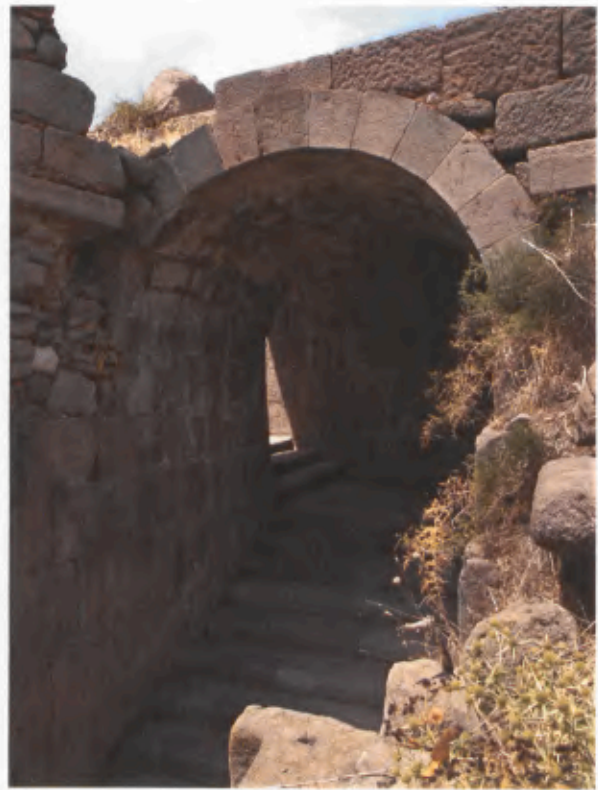
2 Das 1902 instandgesetzte hellenistische Tonnengewölbe über dem westlichen Aufgang zur mittleren Gymnasiumsterrasse in Pergamon (2004).
