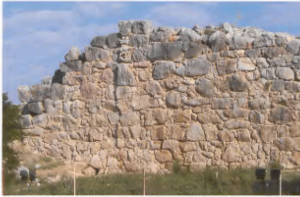
13 Außenmauer West, nördlicher Abschnitt nach Stabilisierung, 2004.
