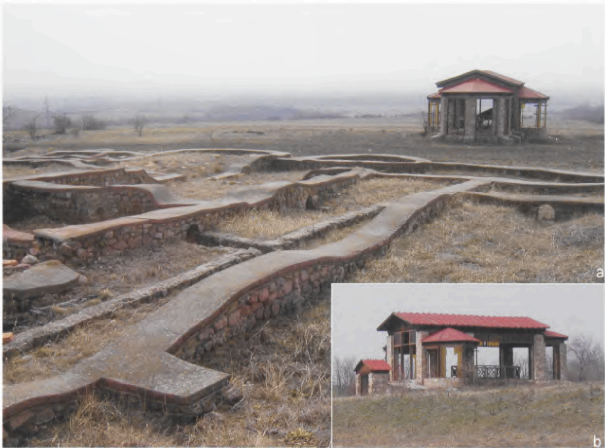
17a–b Heutiger Zustand der in Kővágószőlős entdeckten villa suburbana mit einem Mausoleum. Die erhaltenen Mauern des Villengebäudes wurden nur minimal erhöht und mit Beton-Kunststein bedeckt, der sich „zuckergußartig“ über die Mauern erstreckt (a). Die dreidimensionale Rekonstruktion des Mausoleums wurde durch Vandalismus weitgehend zerstört (b).
