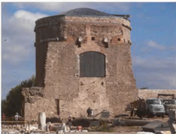
27 Die Westfassade des südlichen Rundturms nach Abschluss der Restaurierungsarbeiten an Mauerwerk und Kuppel (2008).
