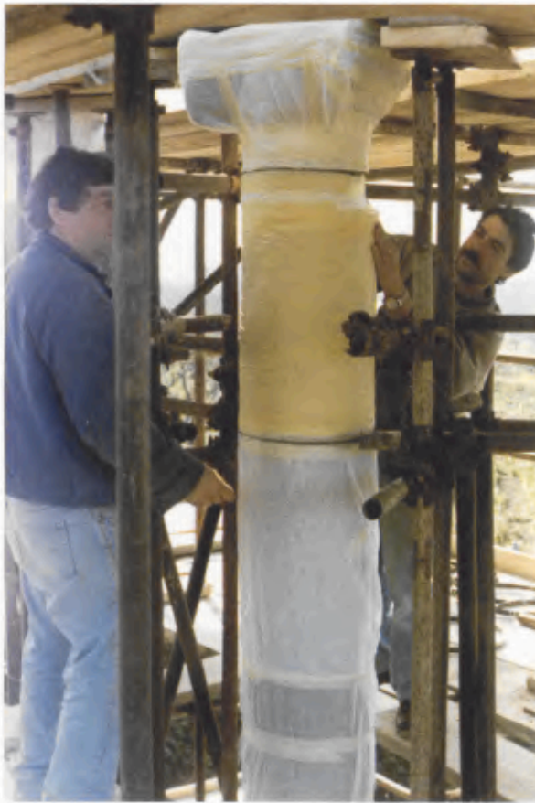
20 Pompeji, Mausoleum der Istacidier, obere Ordnung, Bandagierung der mittleren Säule.
