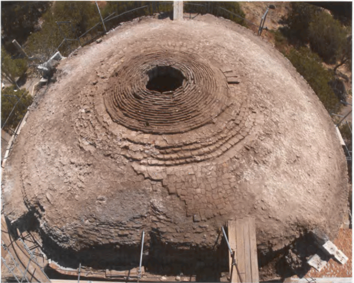
26 Blick auf die gereinigte Kuppeloberfläche des südlichen Rundturms vor Beginn der Restaurierungsarbeiten (2008).
