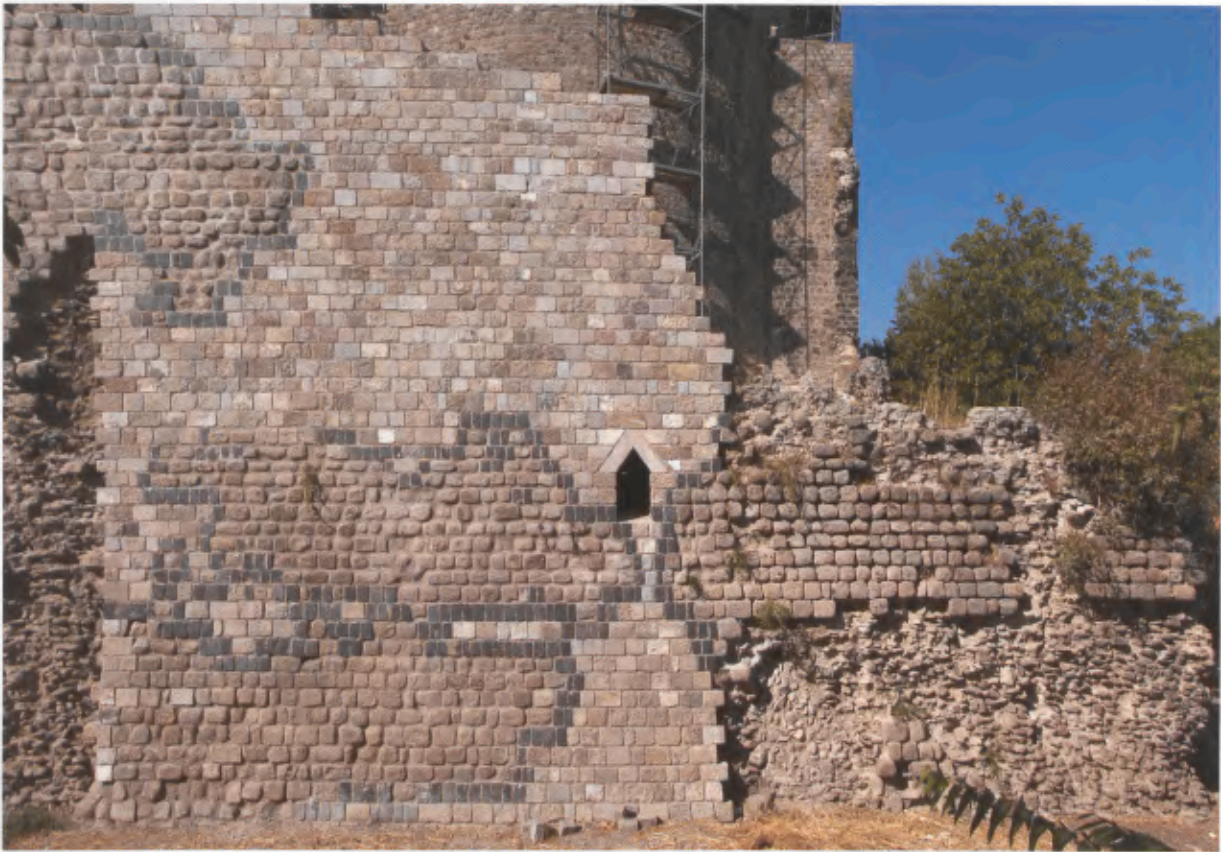
23 Der restaurierte Abschnitt der großen Stützmauer des Temenos der Roten Halle (2007).
